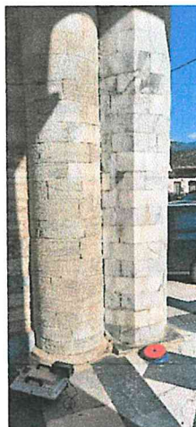
Εικόνα 5.2: Φωτογραφία από το παλιό (αριστερά) και το νέο (δεξιά) υποστύλωμα του καμπαναριού.
