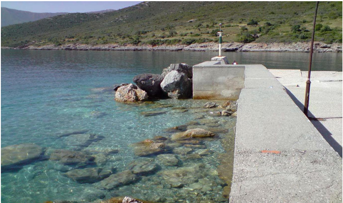
Φωτ. 4: Υπολείμματα θωράκισης από φυσικούς ογκόλιθους της προσήνεμης πλευράς του μώλου.
