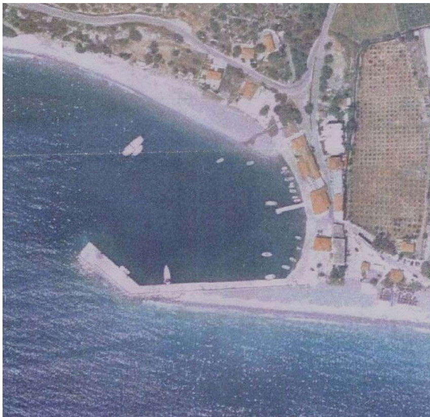
Φωτ. 1: Αεροφωτογραφία λιμένα Λεωνιδίου.
