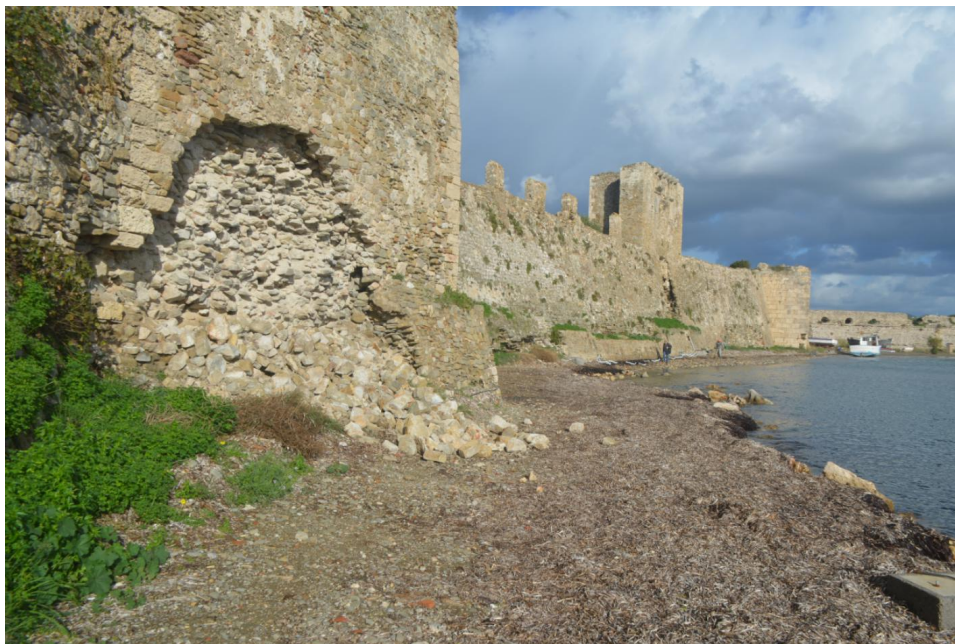
Αποκόλληση και κατάρρευση λίθων σε μεταπύργιο διάστημα (ανάμεσα στους πύργους 7 και 8) του ανατολικού τείχους του κάστρου Μεθώνης κατά την 7η Δεκεμβρίου 2020.
