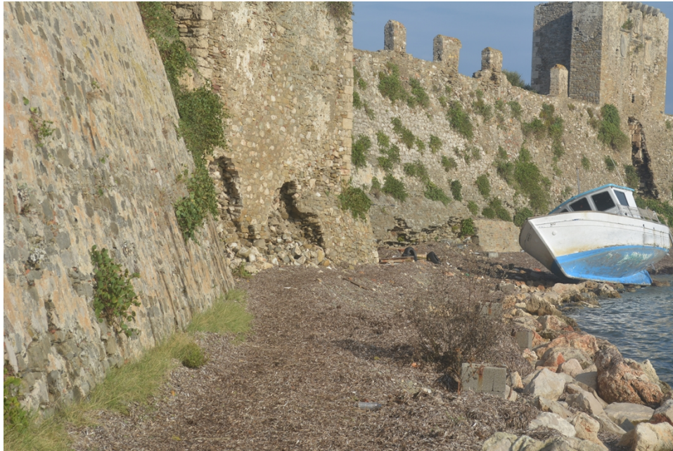
Αποκόλληση και κατάρρευση λίθων σε μεταπύργιο διάστημα (ανάμεσα στους πύργους 7 και 8) του ανατολικού τείχους του κάστρου Μεθώνης κατά την 12η Σεπτεμβρίου 2019.
