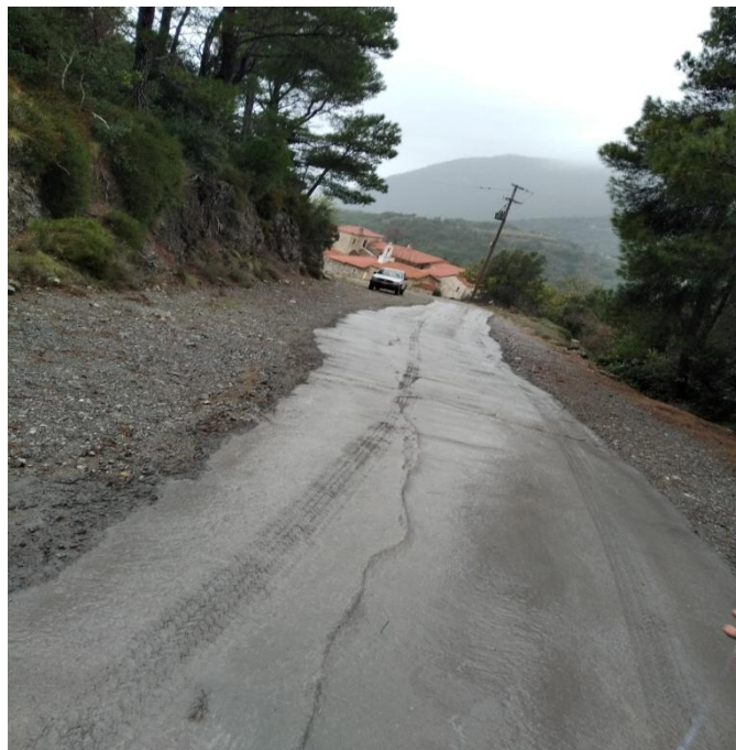
Εικόνα 9: Υφιστάμενη κατάσταση οδοστρώματος στο τμήμα Β
