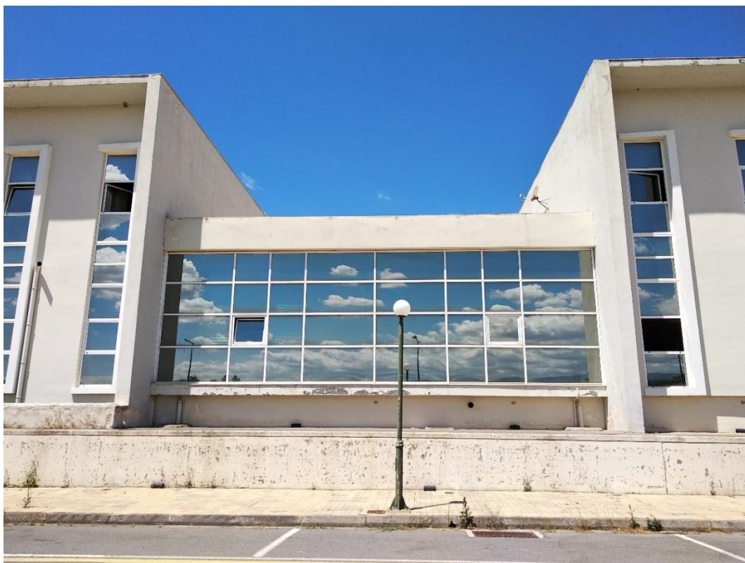
Εικόνα 34 Ανατολική όψη τμήμα ενδιαμέσο
