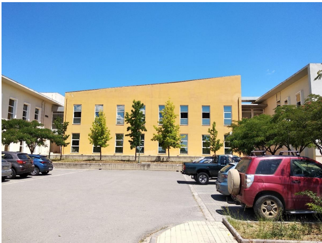
Εικόνα 44 Νότια όψη τμήμα ΙΙΙ
