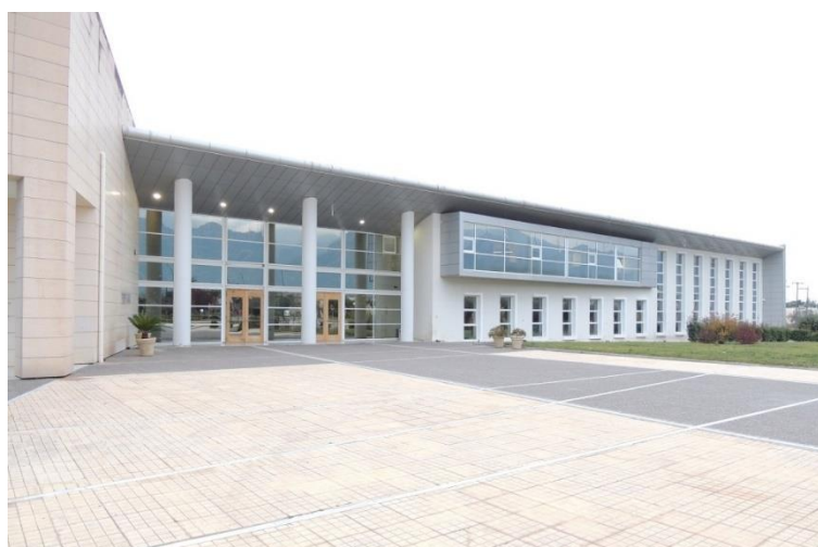
Εικόνα 7 Το προς επιθεώρηση κτίριο: Το Διοικητήριο Σπάρτης
