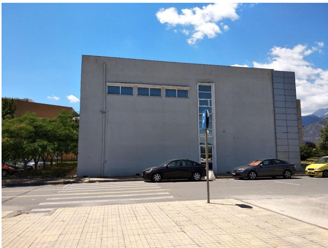
Εικόνα 40 Βόρεια όψη τμήμα I
