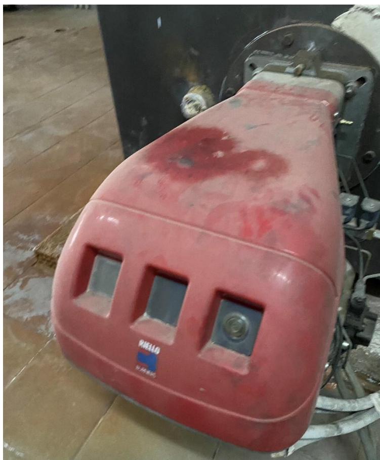
Εικόνα 65 Ο καυστήρας του λέβητα
