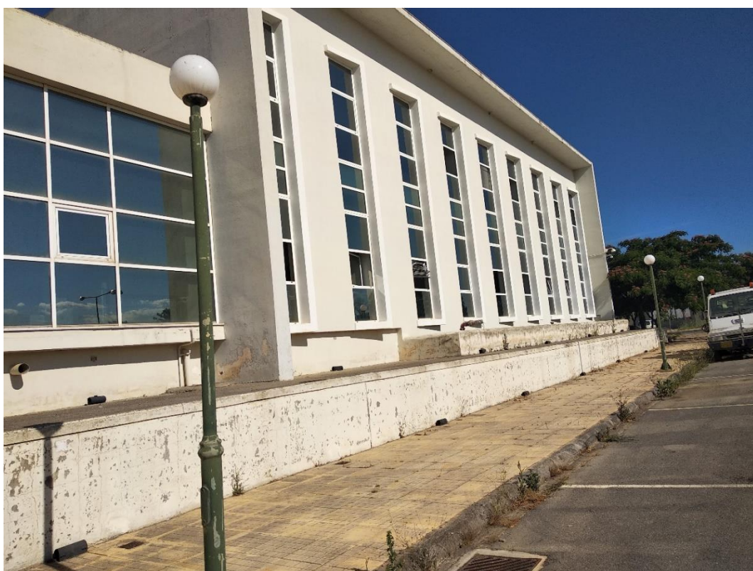
Εικόνα 35 Ανατολική όψη τμήμα IV
