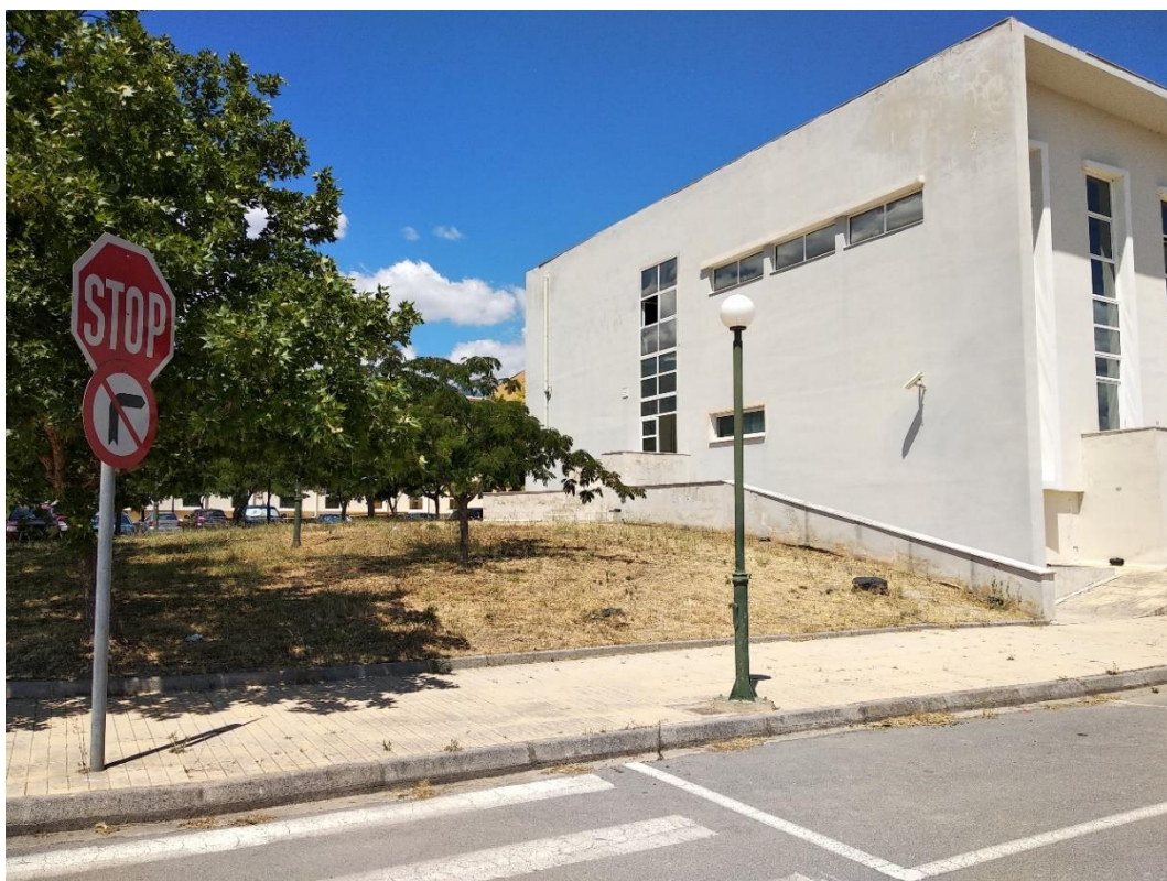
Εικόνα 45 Νότια όψη τμήμα V
