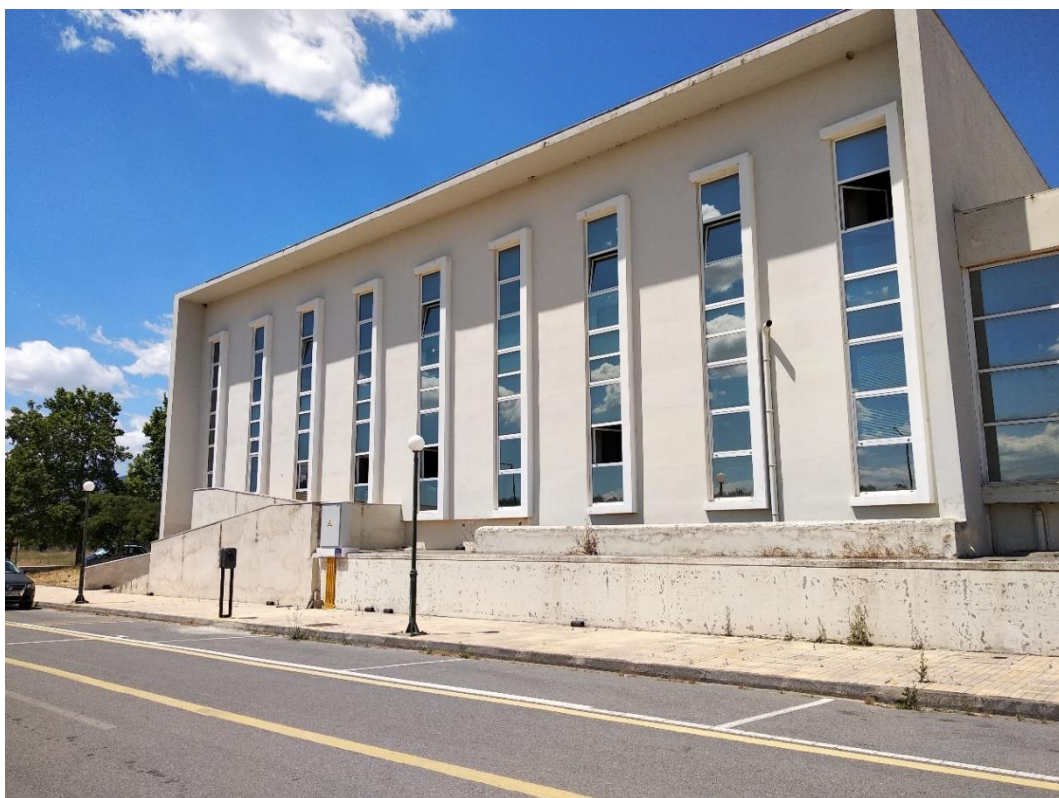
Εικόνα 33 Ανατολική όψη τμήμα V
