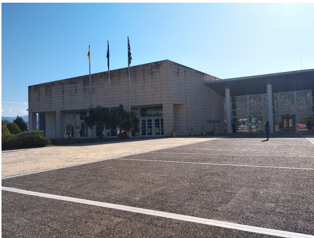
Εικόνα 37 Δυτική όψη τμήμα Ι
