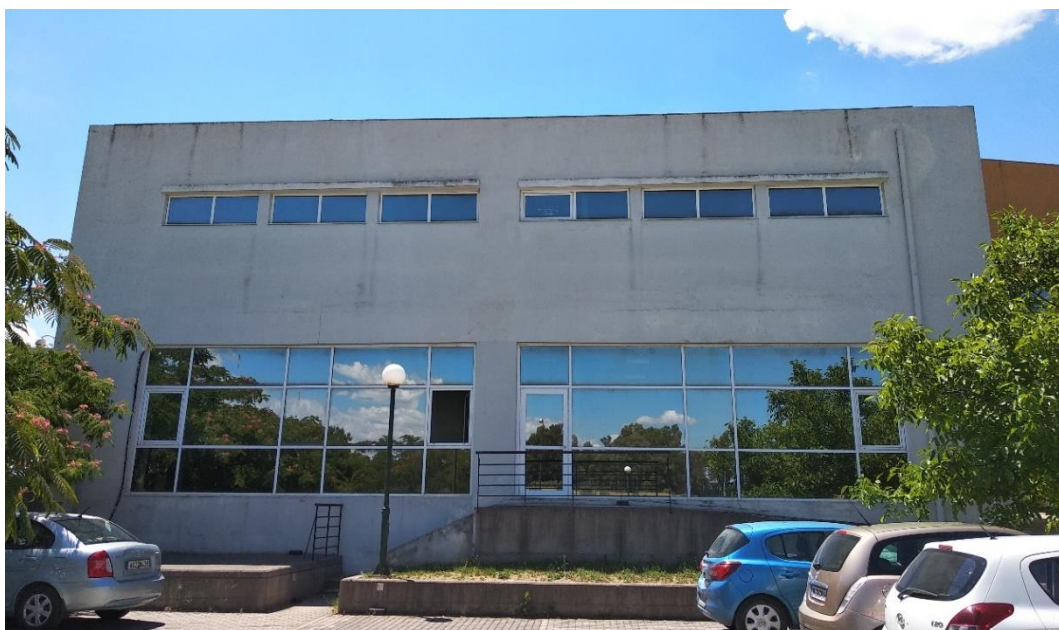
Εικόνα 42 Βόρεια όψη τμήμα IV
