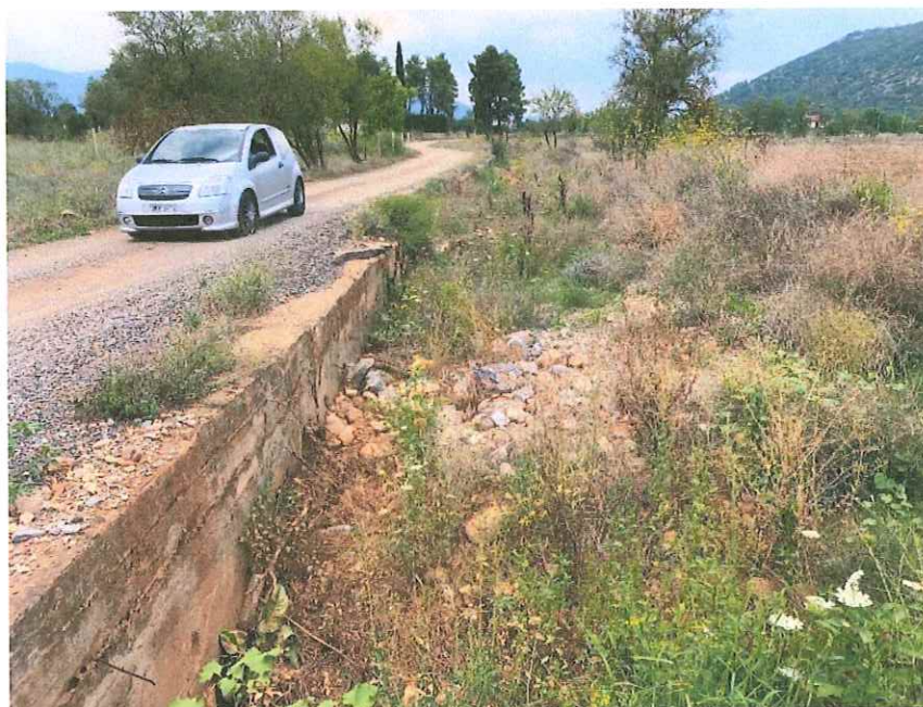
Εικόνα Τ1. Ανάντη αρχή ΑΤ2 – Περιοχή Φρεατίου Μερισμού ΦΜ1
