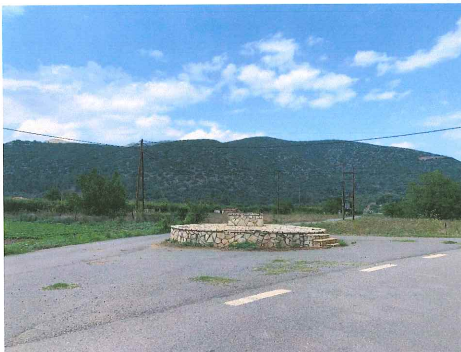
Εικόνα T11. Περιοχή Ανάντη αρχής ΑΤ5 όπου συμβάλλουν οι ΑΤ4 και ΑΤ7 (Δεξιά της Ε.Ο. Τρίπολης – Νεοχωρίου)
