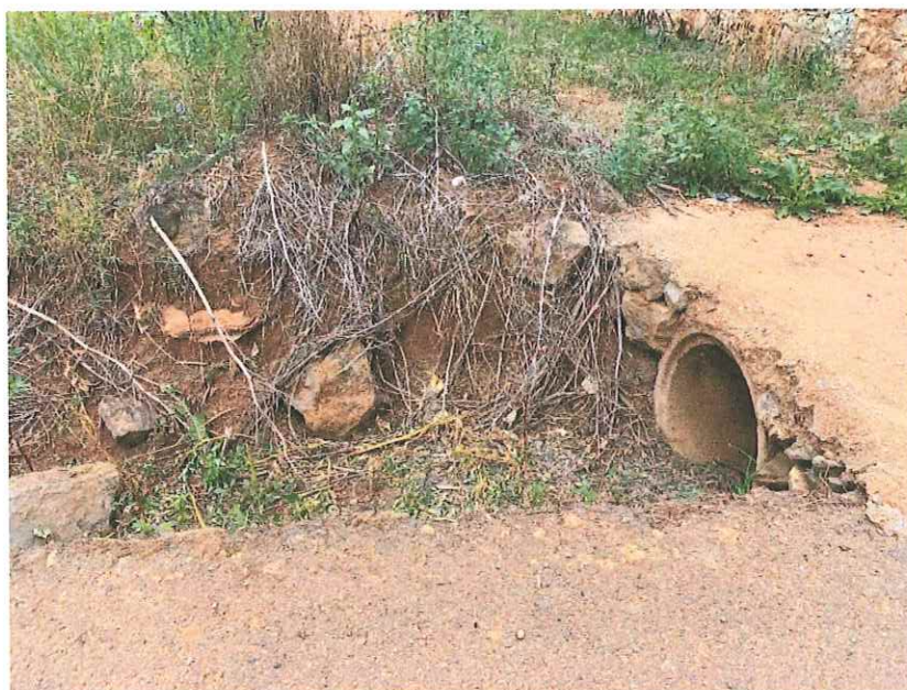
Εικόνα Z7. Υφιστάμενη τάφρος Ζευγολατειού. Ανεπένδυτο τμήμα. Διάβαση οδού προσπέλασης. / 1
