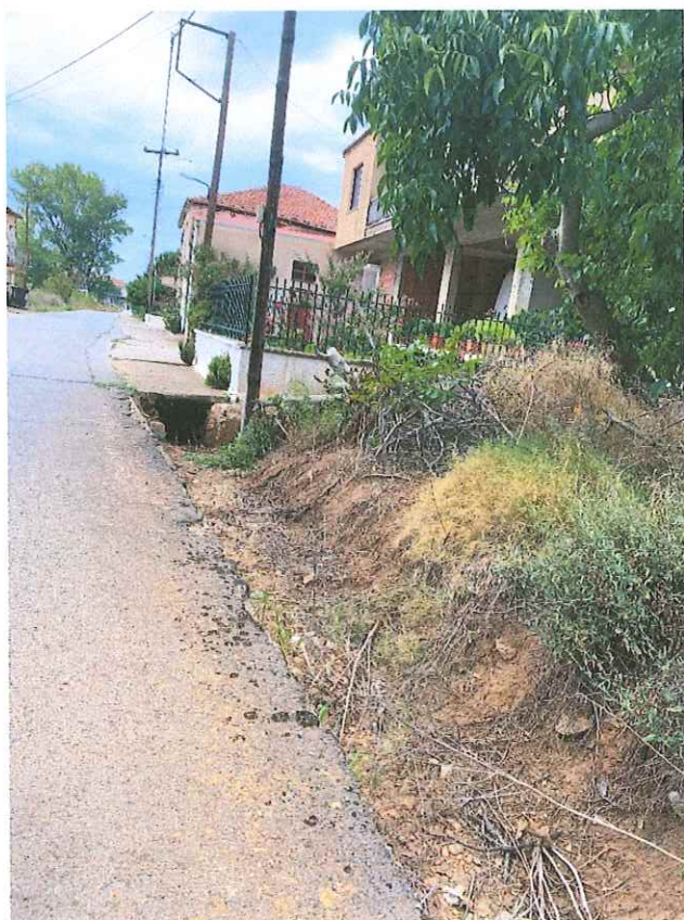
Εικόνα Z10. Υφιστάμενη τάφρος Ζευγολατειού. Ανεπένδυτο τμήμα. Στο τέλος του ανεπένδυτου τμήματος η τάφρος Εγκιβωτίζεται σε ορθογωνική διατομή από σκυρόδεμα και διέρχεται καλυμμένη τον οικισμό του Ζευγολατειού.
