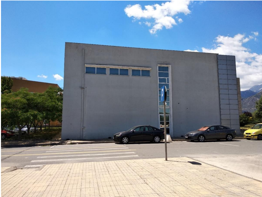
Εικόνα 40 Βόρεια όψη τμήμα Ι
