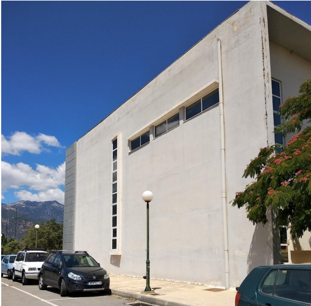
Εικόνα 43 Νότια όψη τμήμα ΙΙ
