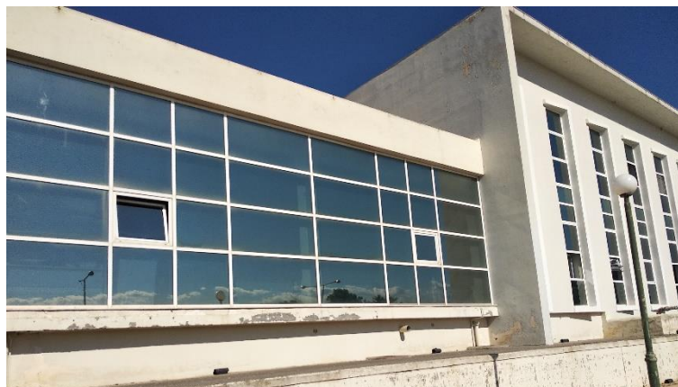
Εικόνα 50 Κουφώματα του κτιρίου
