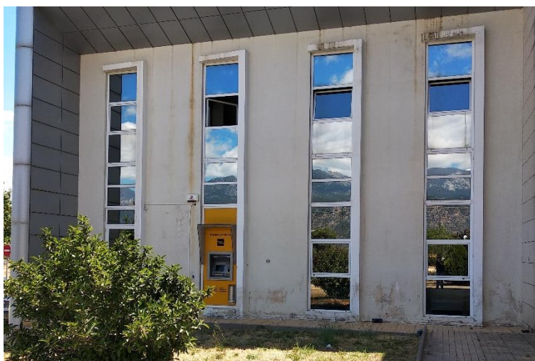
Εικόνα 47 Κουφώματα του κτιρίου
