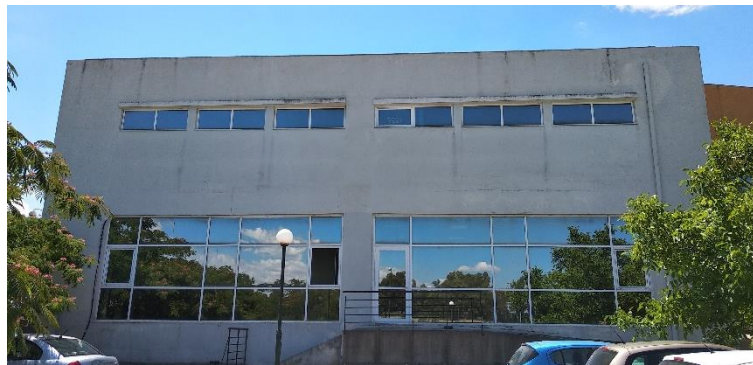
Εικόνα 49 Κουφώματα του κτιρίου
