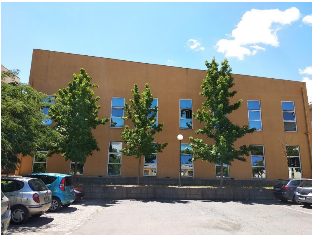
Εικόνα 41 Βόρεια όψη τμήμα ΙΙΙ
