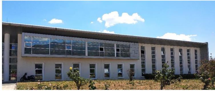
Εικόνα 48 Κουφώματα του κτιρίου
