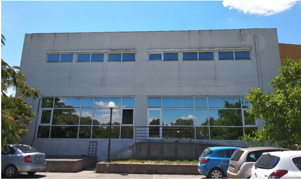
Εικόνα 42 Βόρεια όψη τμήμα IV
