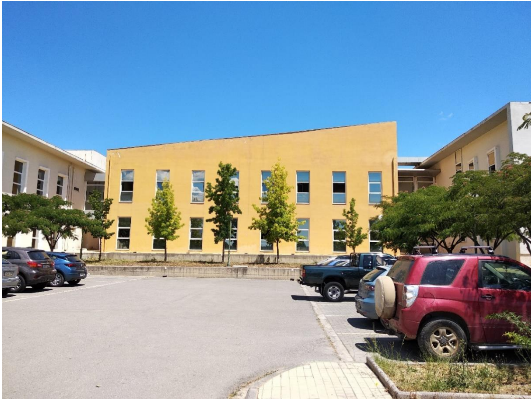
Εικόνα 44 Νότια όψη τμήμα ΙΙΙ
