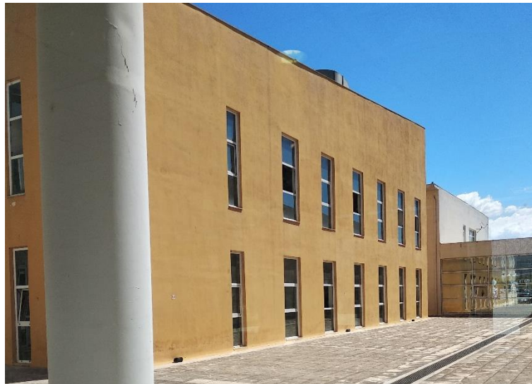
Εικόνα 51 Κουφώματα του κτιρίου
