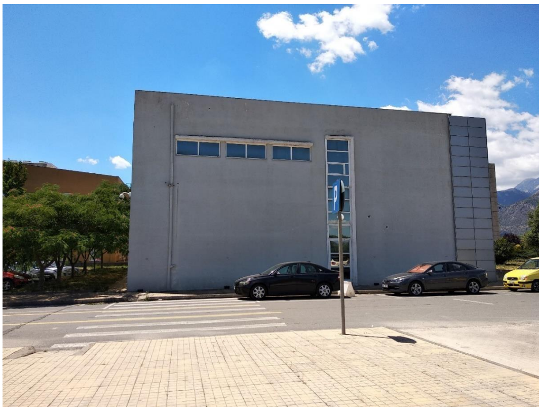
Εικόνα 40 Βόρεια όψη τμήμα I
