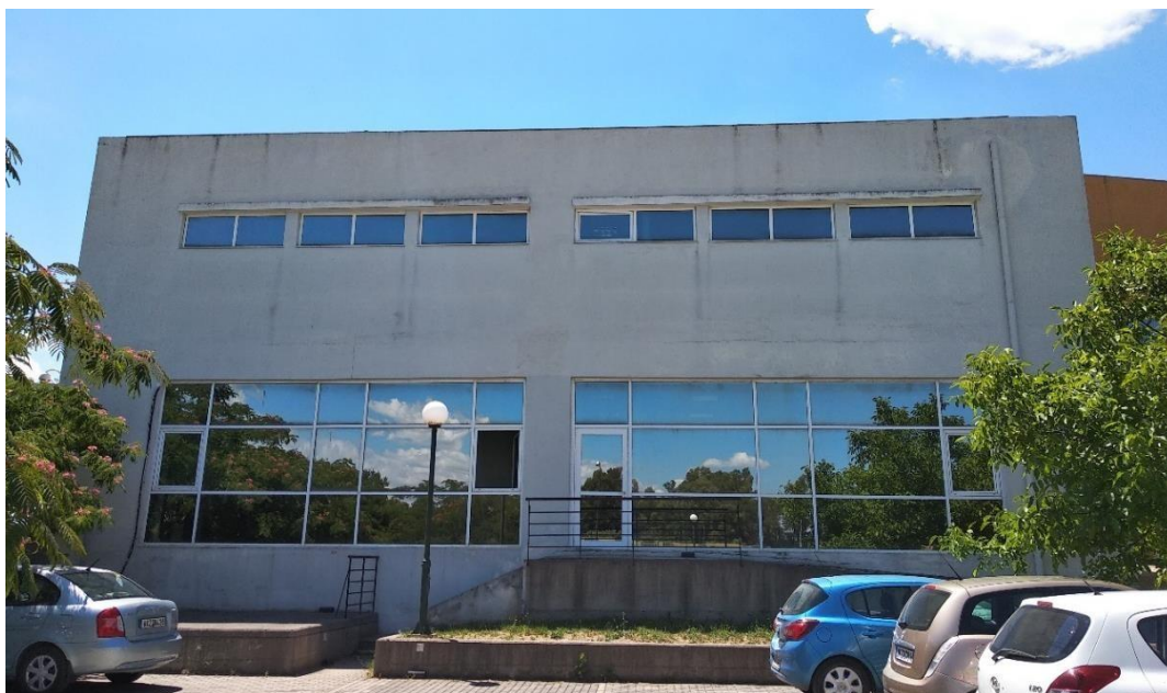
Εικόνα 42 Βόρεια όψη τμήμα IV
