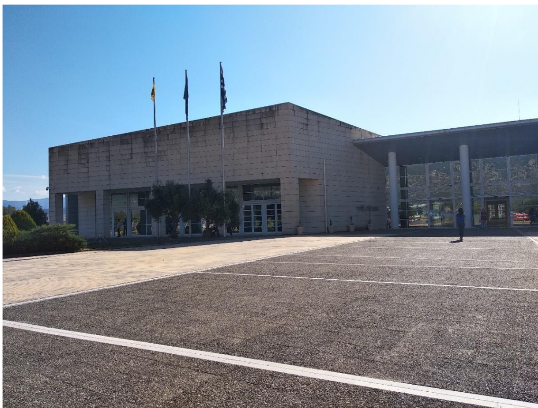
Εικόνα 37 Δυτική όψη τμήμα Ι
