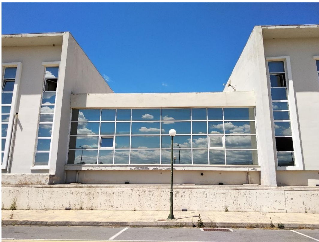
Εικόνα 34 Ανατολική όψη τμήμα ενδιαμέσο
