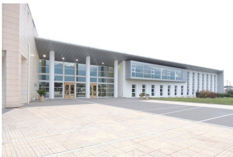
Εικόνα 7 Το προς επιθεώρηση κτίριο: Το Διοικητήριο Σπάρτης
