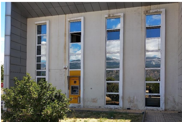
Εικόνα 47 Κουφώματα του κτιρίου
