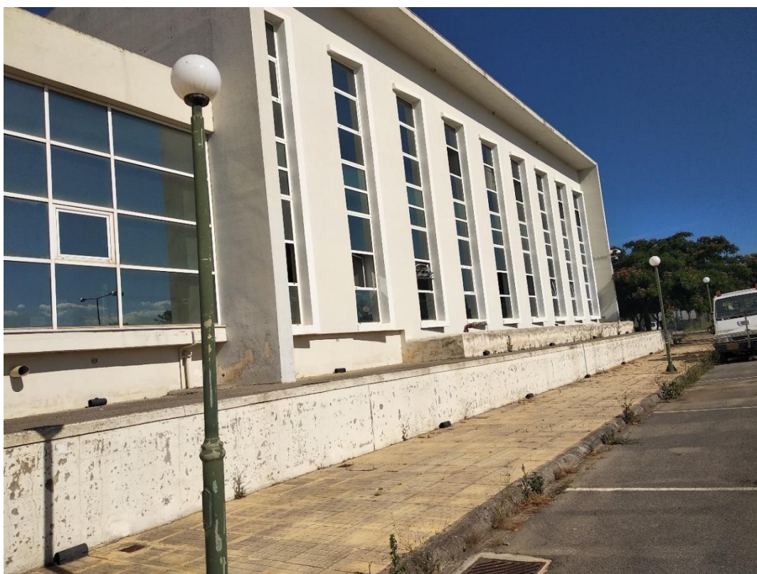
Εικόνα 35 Ανατολική όψη τμήμα IV
