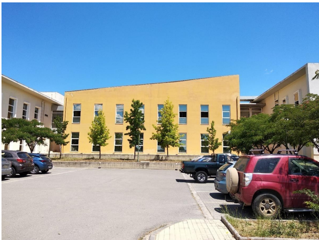
Εικόνα 44 Νότια όψη τμήμα ΙΙΙ
