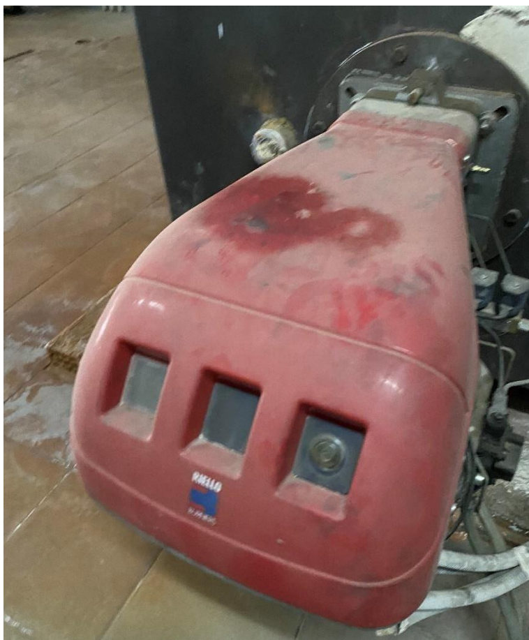
Εικόνα 65 Ο καυστήρας του λέβητα
