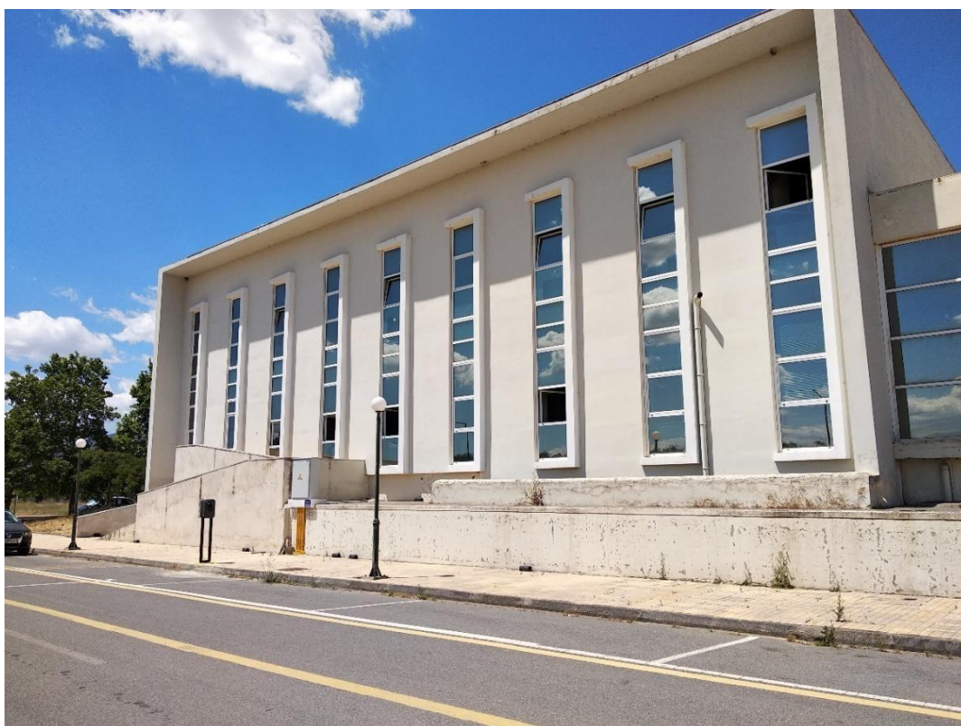
Εικόνα 33 Ανατολική όψη τμήμα V
