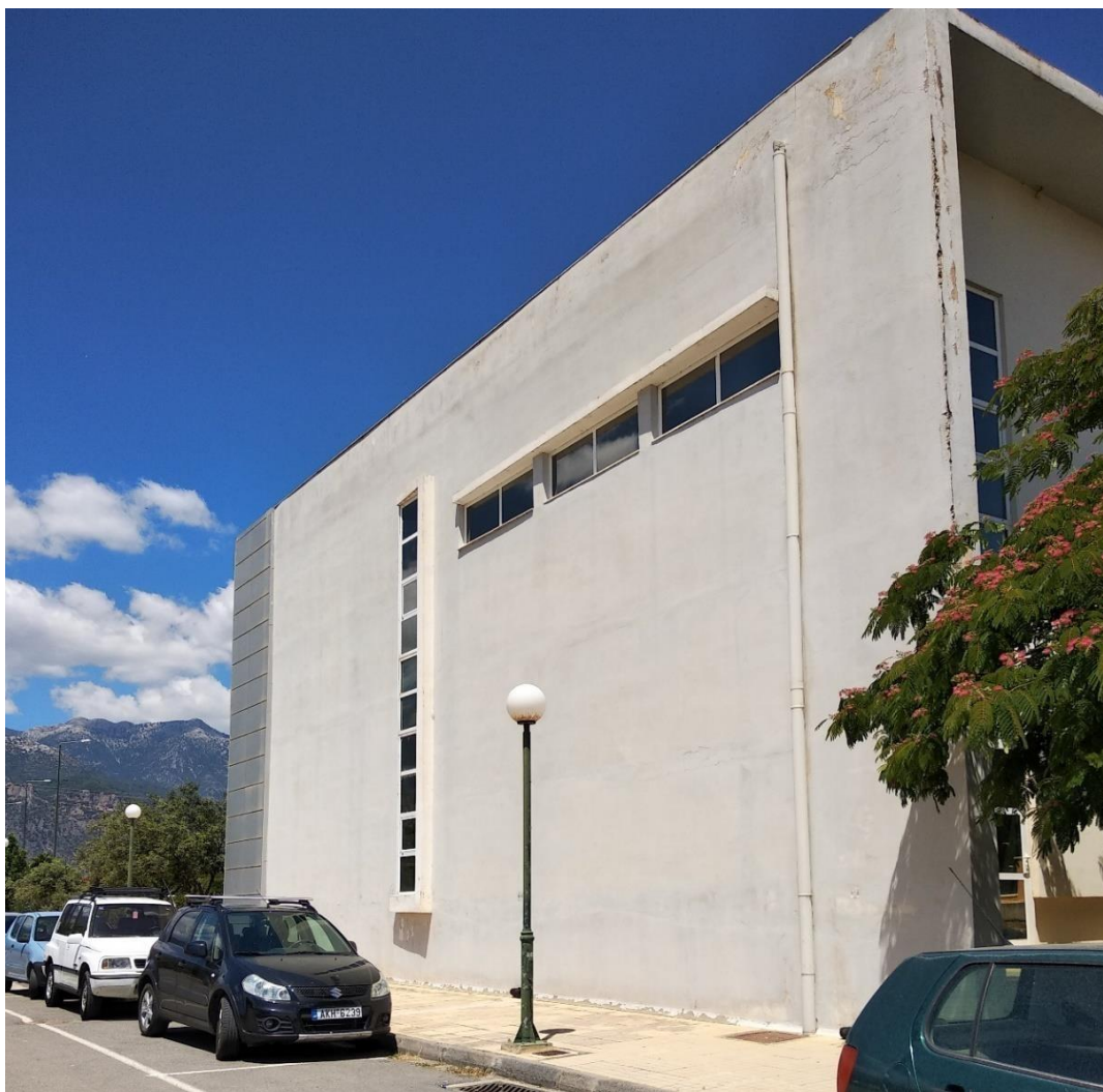
Εικόνα 43 Νότια όψη τμήμα ΙΙ
