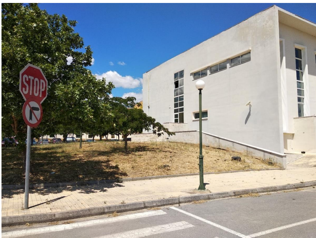
Εικόνα 45 Νότια όψη τμήμα V
