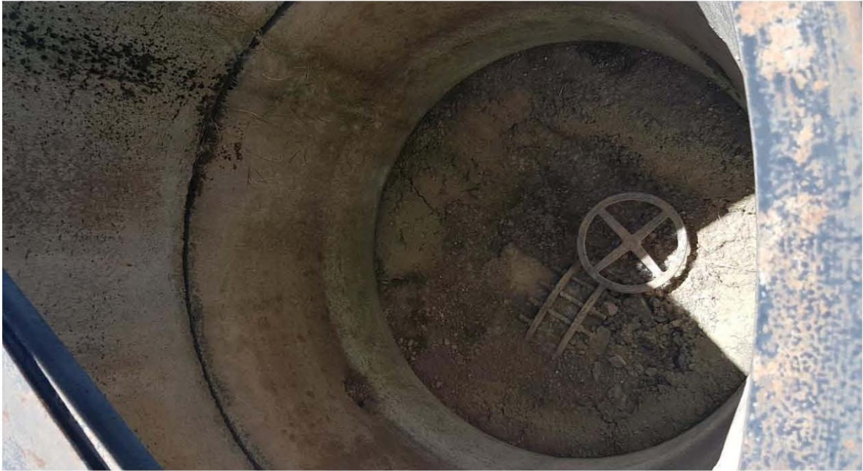
Εικ. 3. Βάνα Χειροκίνητης απομόνωσης σε δυσλειτουργία
