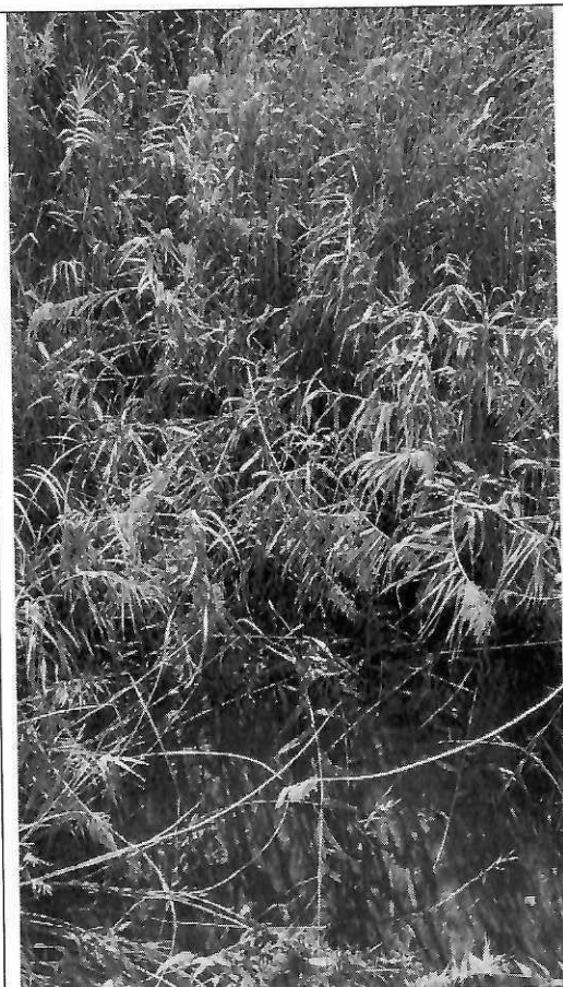
Φωτ. 1 Θέα κατάντη της γέφυρας. Έντονη βλάστηση και στάσιμο νερό.
