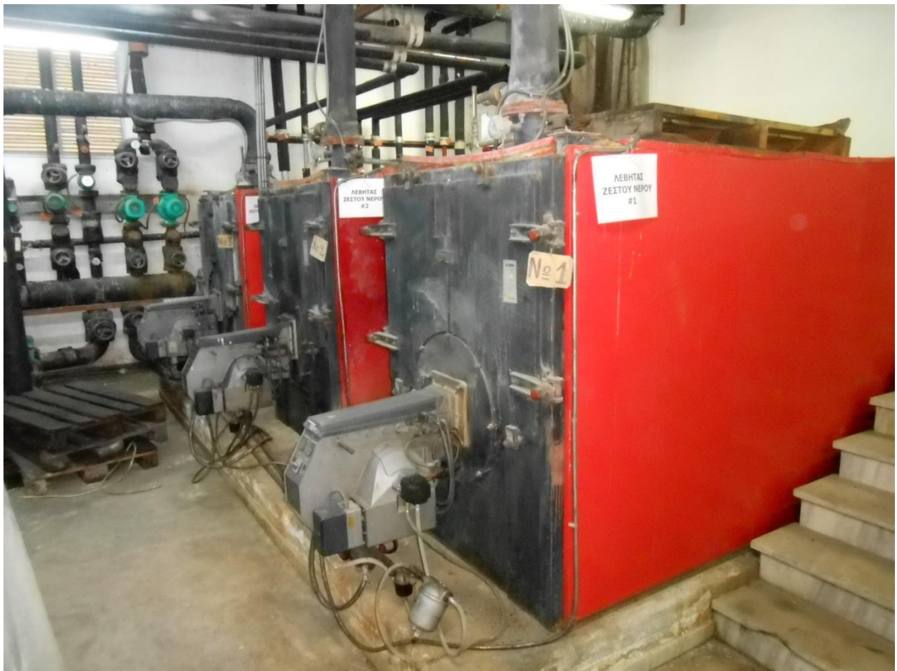
Εικόνα 15: Λεβητοστάσιο – Καυστήρες
