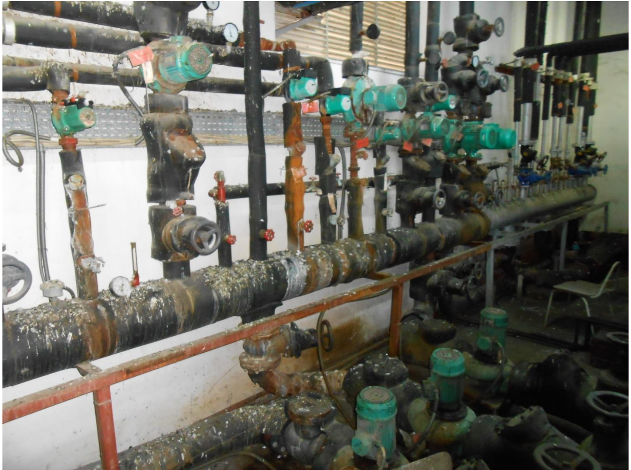
Εικόνα 16: Κεντρικός Συλλέκτης Διανομής - Λεβητοστάσιο
