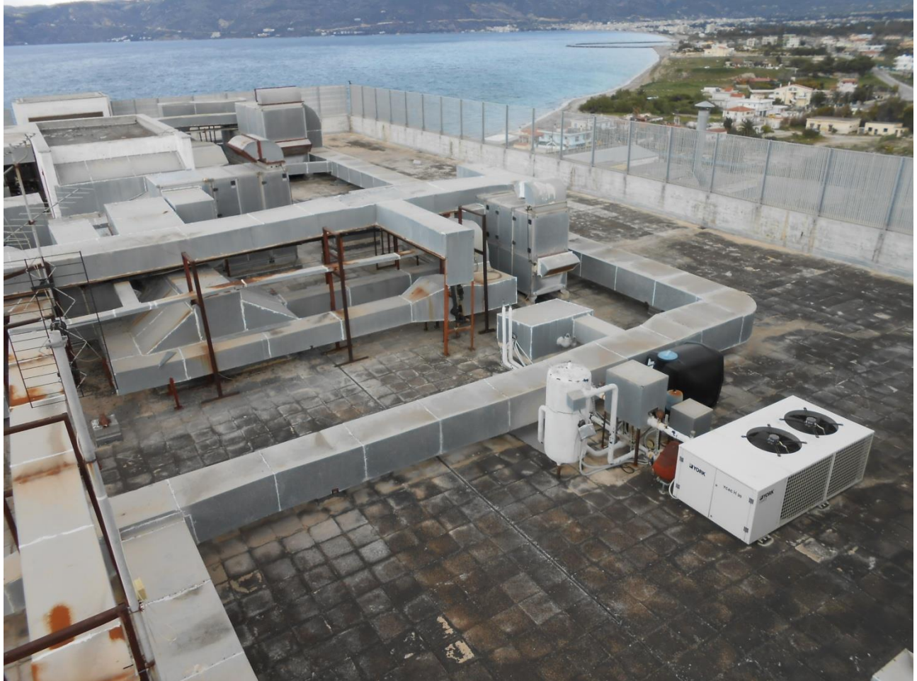
Εικόνα 17 : Κεντρικές Κλιματιστικές Μονάδες
