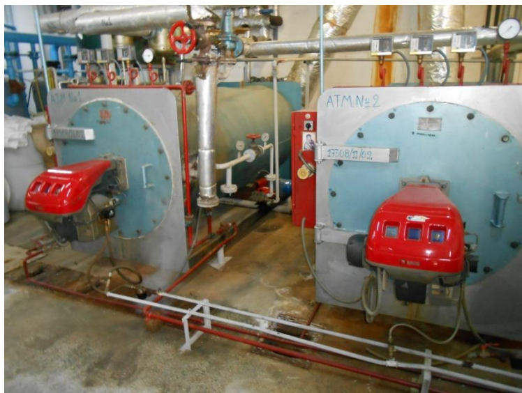
Εικόνα 23: Ατμογεννήτριες της Γενικής Μηχανολογικής Βιομηχανίας με καταναλώσεις στα πλυντήρια, μαγειρεία και το σιδερωτήριο.
