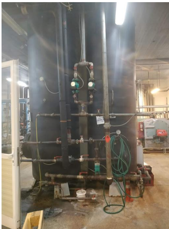
Εικόνα 22: Θερμοδοχεία αποθήκευσης ZNX
