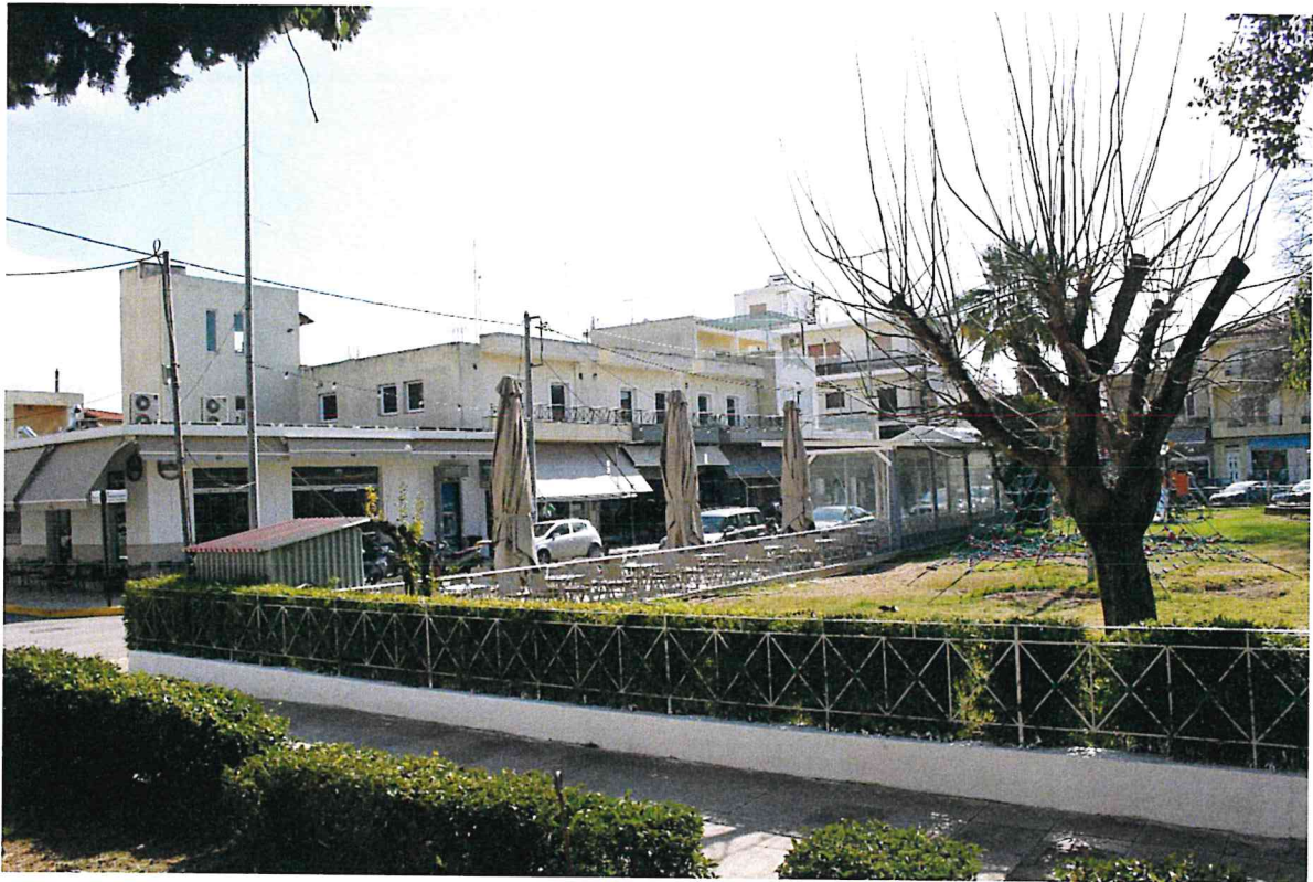
28. ΔΙΑΔΡΟΜΟΣ ΕΙΣΟΔΟΥ ΜΕ ΦΥΤΟΦΡΑΧΤΗ ΣΤΗΝ ΑΝΑΤΟΛΙΚΗ ΠΕΡΙΟΧΗ ΤΗΣ ΠΛΑΤΕΙΑΣ.
