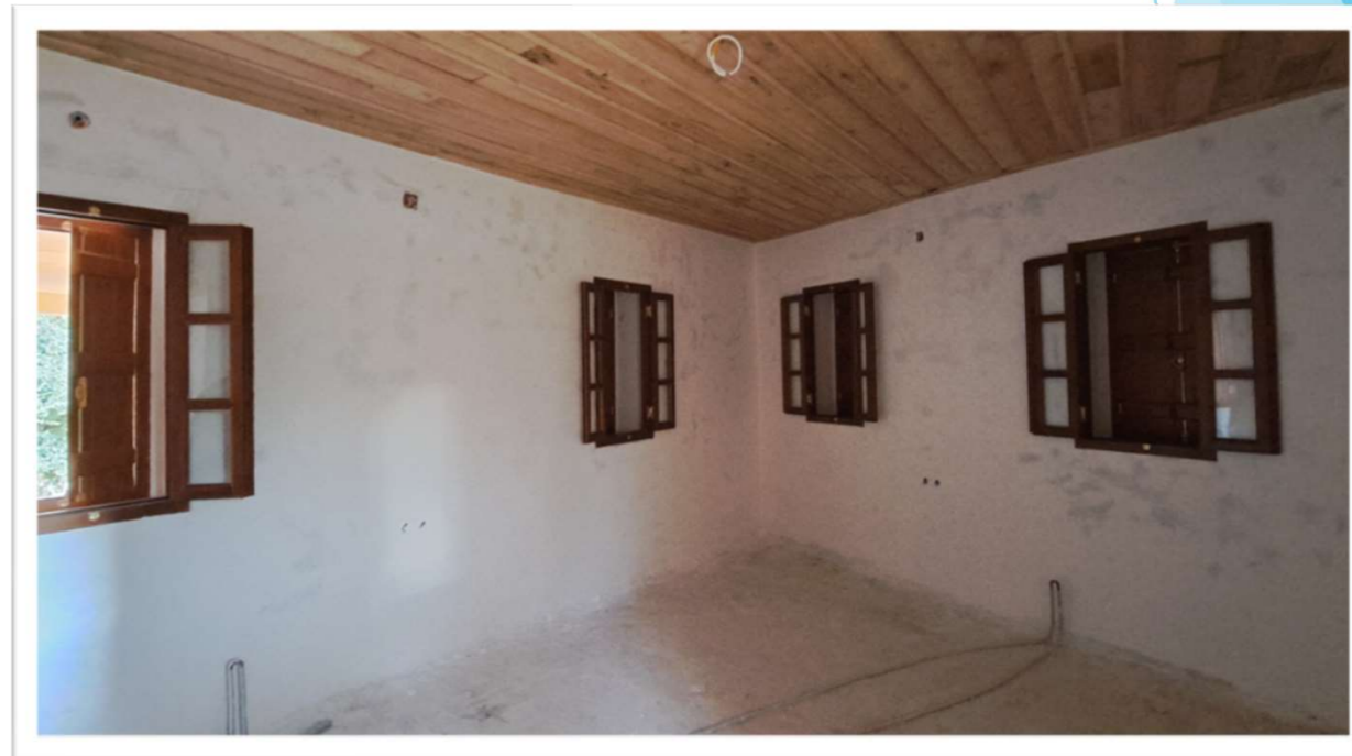
11/2023 | Κατασκευή Ξύλινων Κουφωμάτων
