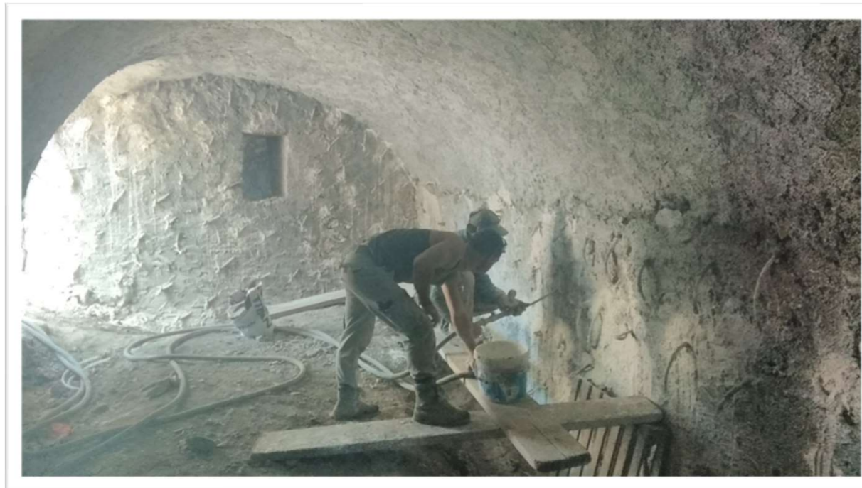
08/2021 | Εφαρμογή Ενεμάτων Λιθοδομών
