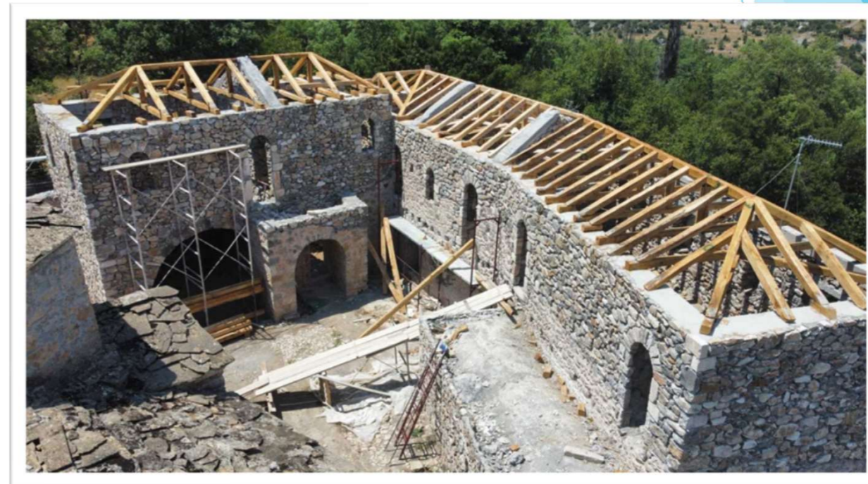
06/2022 | Κατασκευή Φ.Ο. Ξύλινων Στεγών
