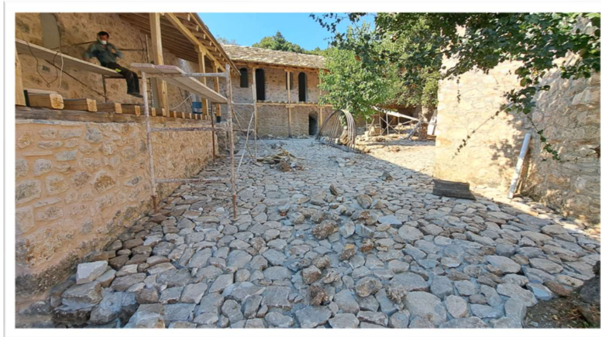
10/2023 | Κατασκευή Εξωτερικού Λιθόστρωτου
