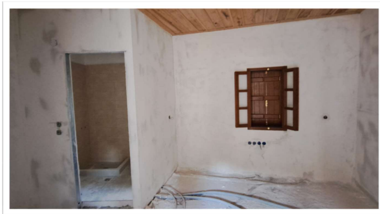
12/2023 | Κατασκευή Χώρων W.C. - Η/Μ Οδεύσεις
