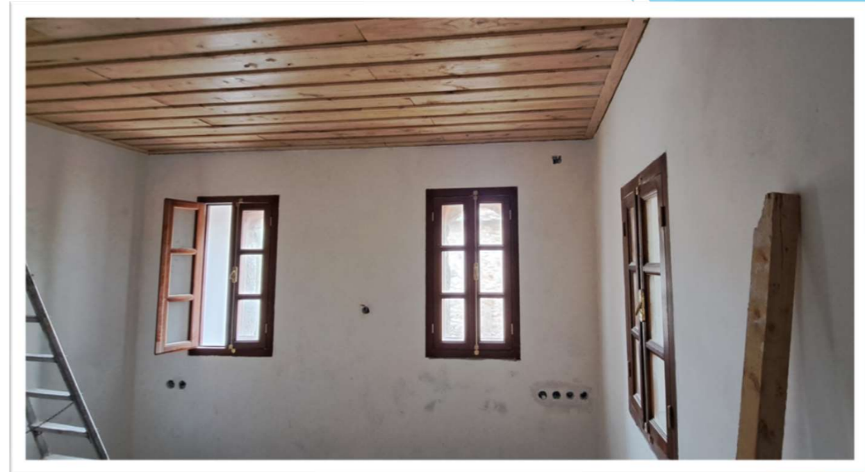
12/2023 | Κατασκευή Ξύλινων Οροφών - Η/Μ
