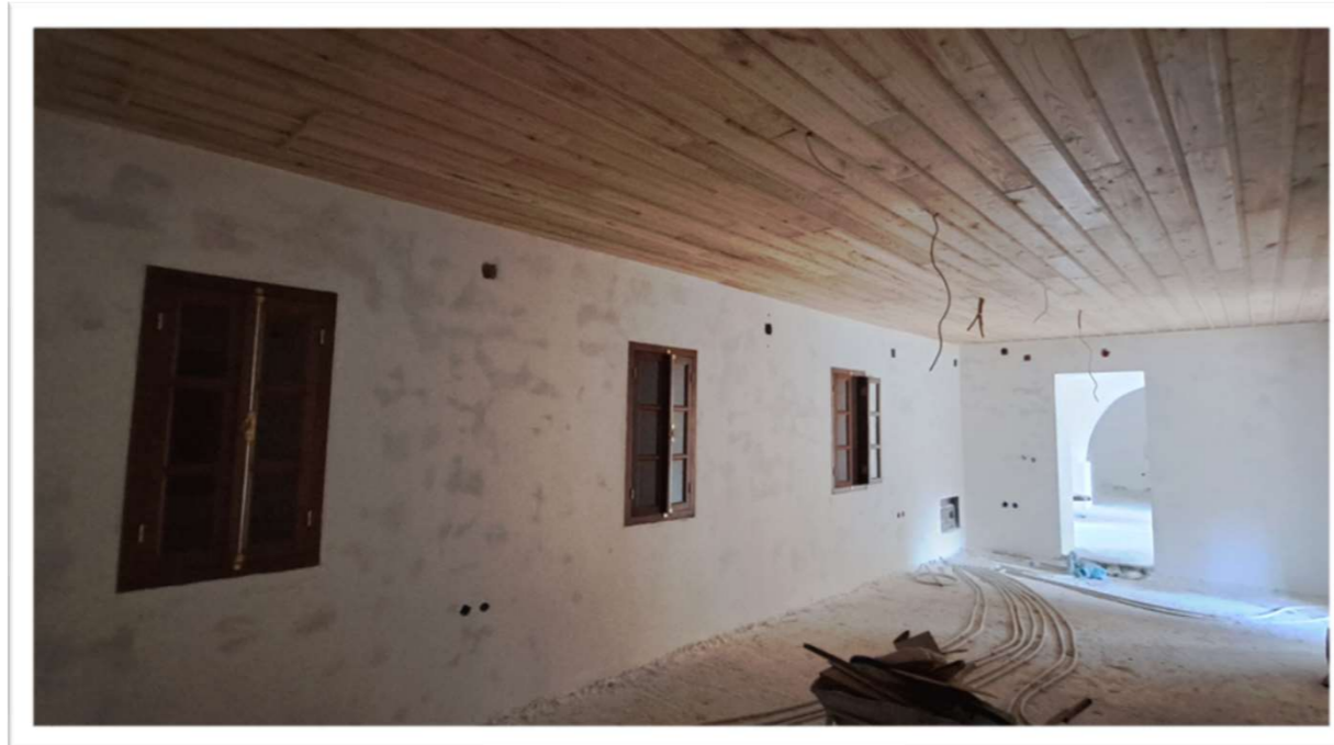
12/2023 | Κατασκευή Ξύλινων Οροφών - Η/Μ
