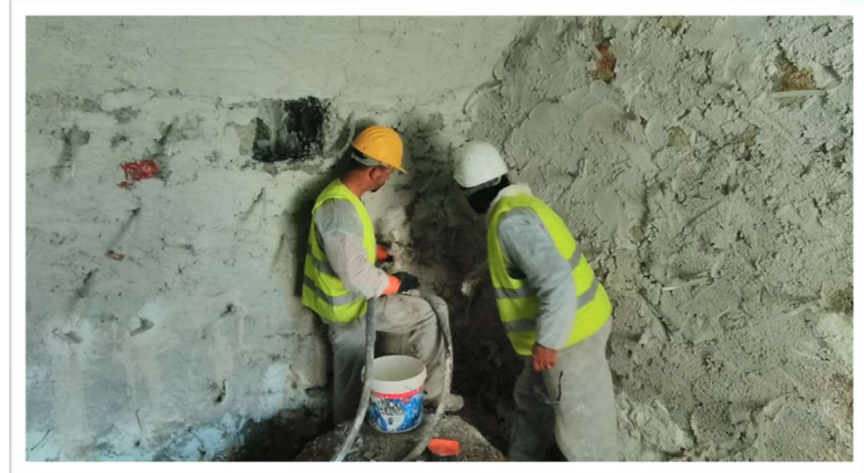
07/2021 | Εφαρμογή Ενεμάτων Λιθοδομών
