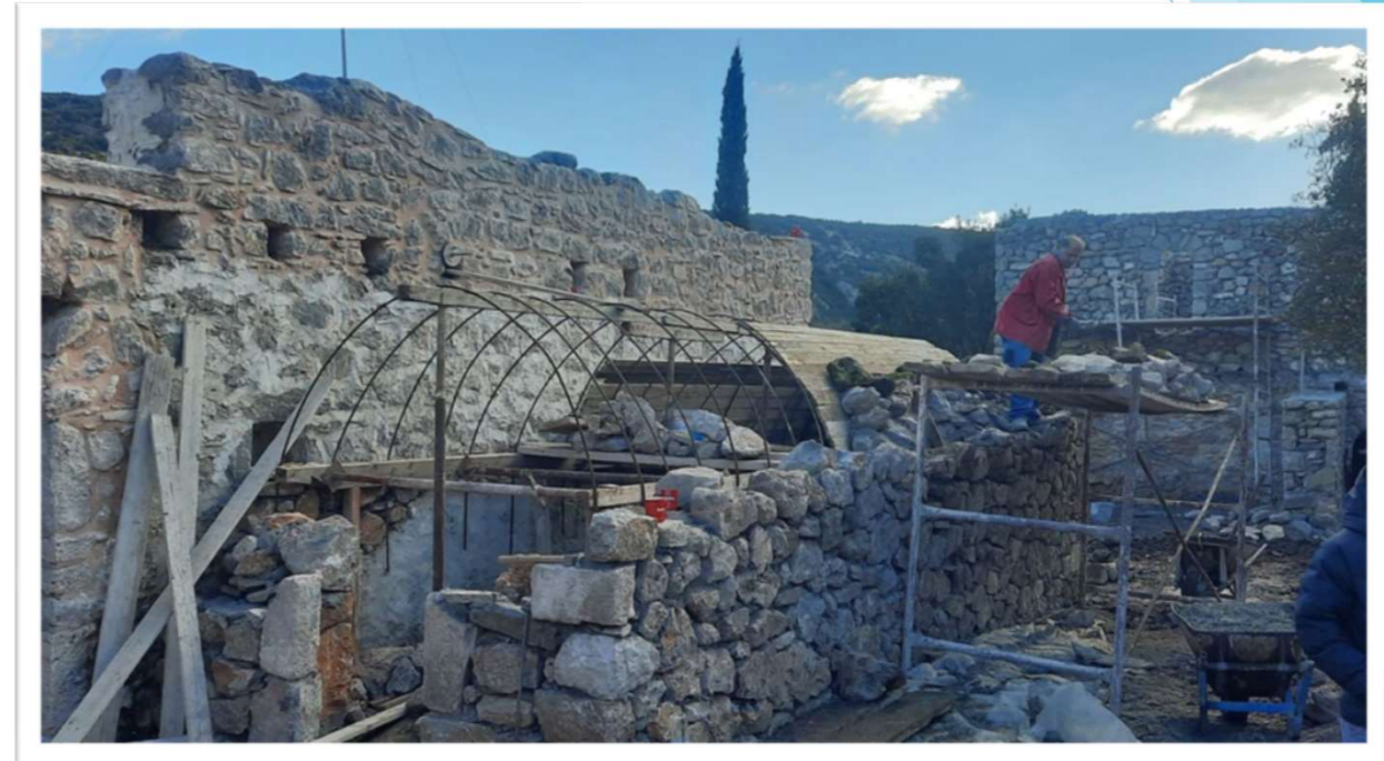
02/2022 | Κατασκευή - Αναδόμηση Λιθοδομών
