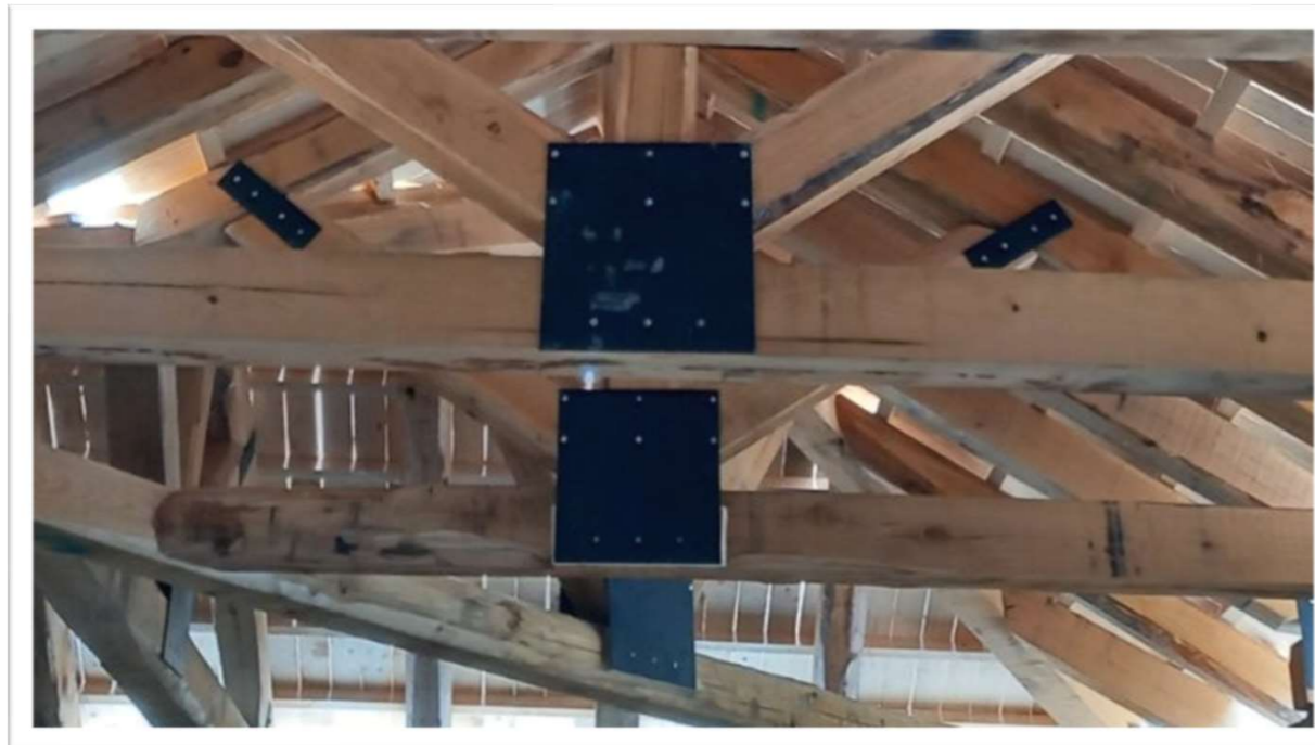
06/2022 | Κατασκευή Ξύλινων Στεγών
