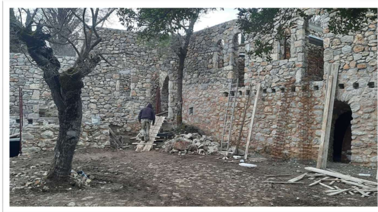
04/2022 | Κατασκευή - Αναδόμηση Λιθοδομών
