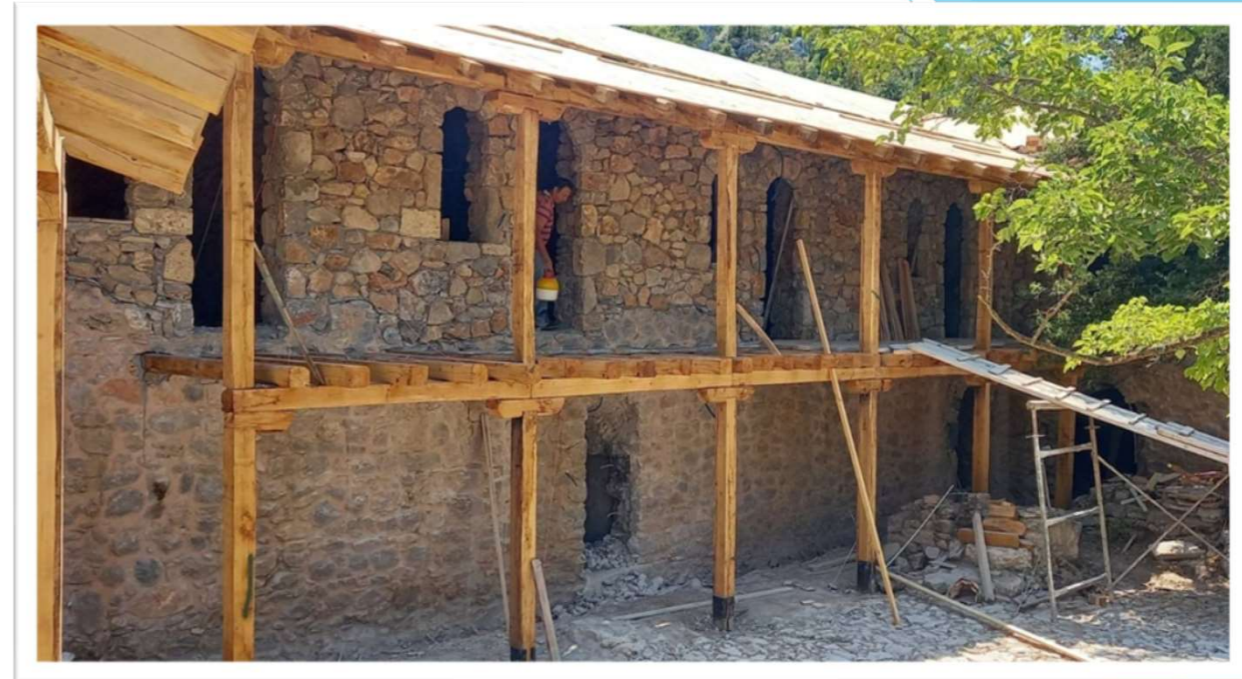
07/2022 | Ξύλινες Κατασκευές - Επιστεγάσεις
