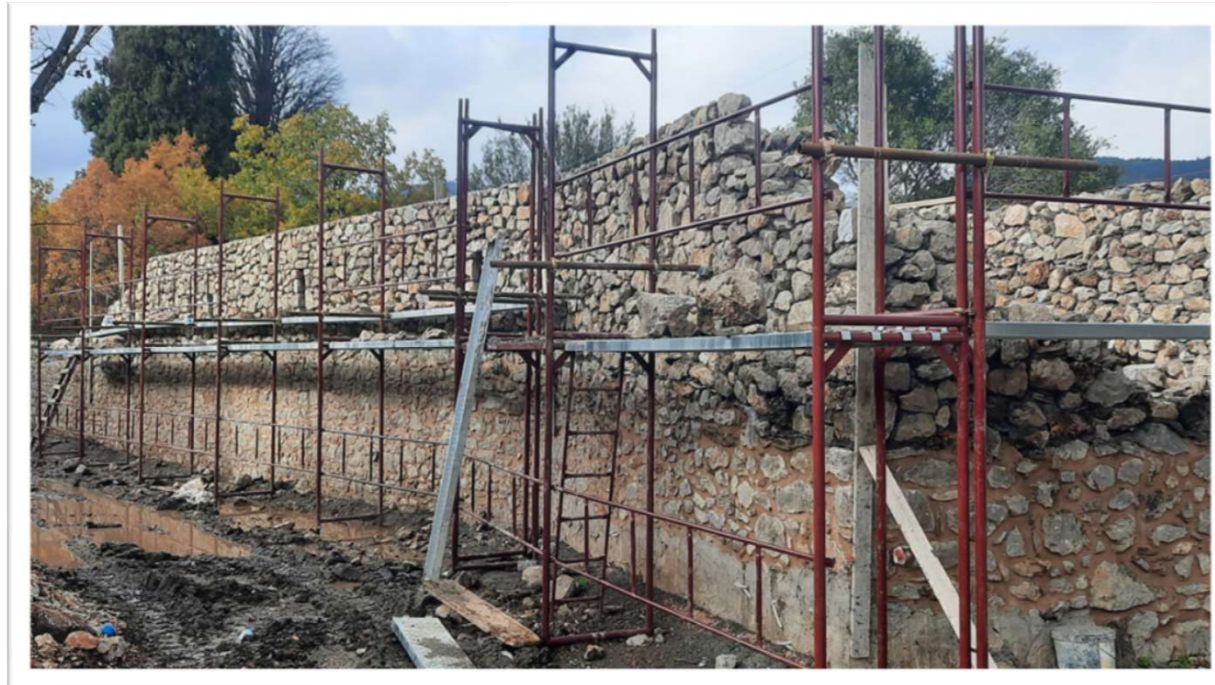
12/2021 | Κατασκευή - Αναδόμηση Λιθοδομών
