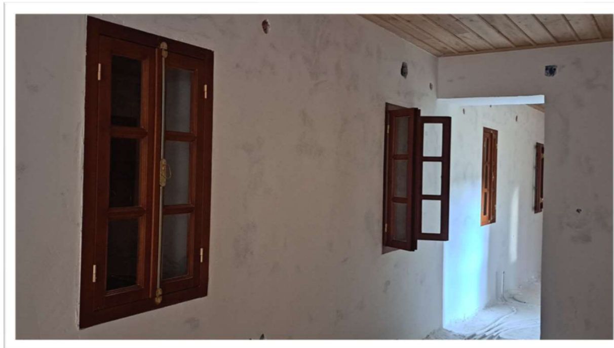
11/2023 | Κατασκευή Ξύλινων Κουφωμάτων
