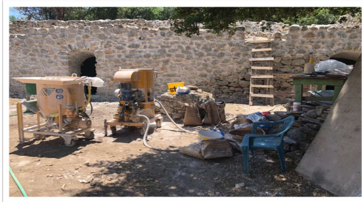
07/2021 | Εξοπλισμός Εφαρμογής Ενεμάτων
