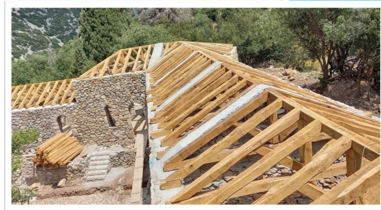
06/2022 | Κατασκευή Φ.Ο. Ξύλινων Στεγών
