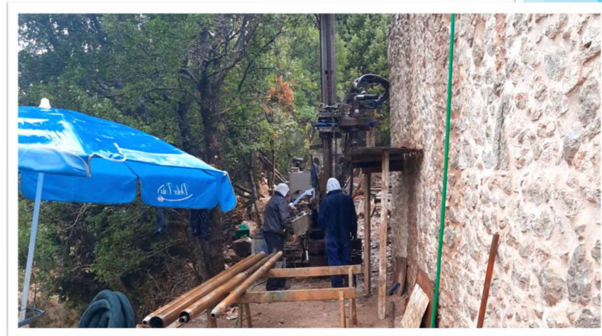
09/2021 | Τσιμεντενέσεις Ενίσχυσης Εδάφους
