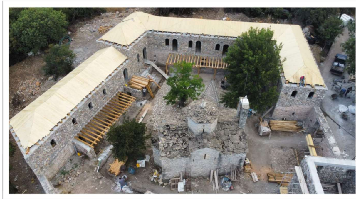
07/2022 | Ξύλινες Κατασκευές - Επιστεγάσεις
