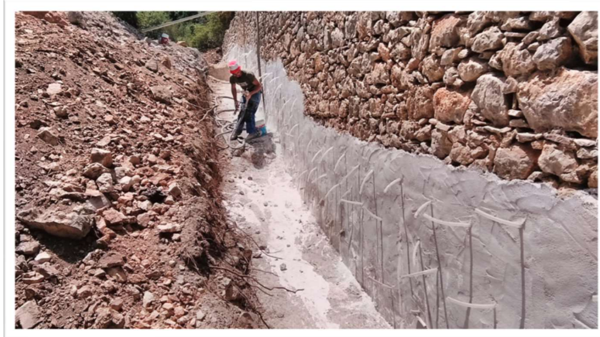
07/2021 | Εφαρμογή Ενεμάτων Λιθοδομών
