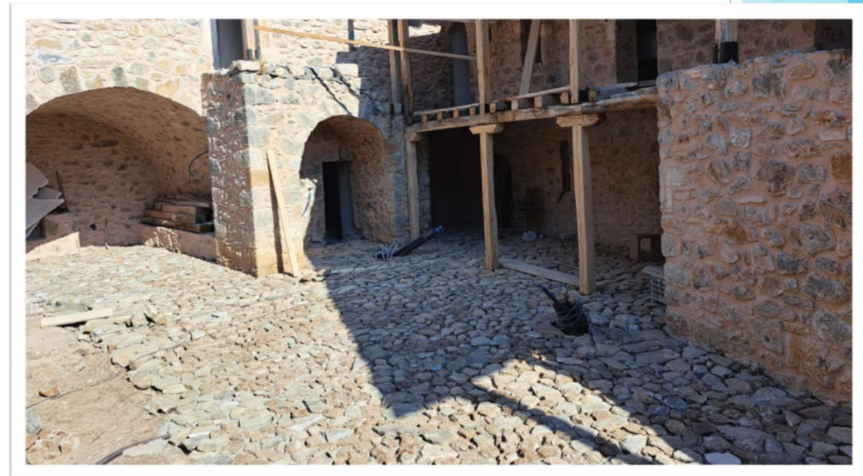
05/2023 | Κατασκευή Εξωτερικού Λιθόστρωτου
