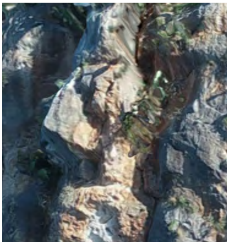
Άποψη του πρανούς Β3 όπου παρατηρούνται δυνητικές ολισθήσεις τεμαχών
