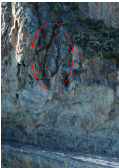
Άποψη του πρανούς N3 όπου σημειώνεται με κόκκινο δυνητικές ολισθήσεις τεμαχών
