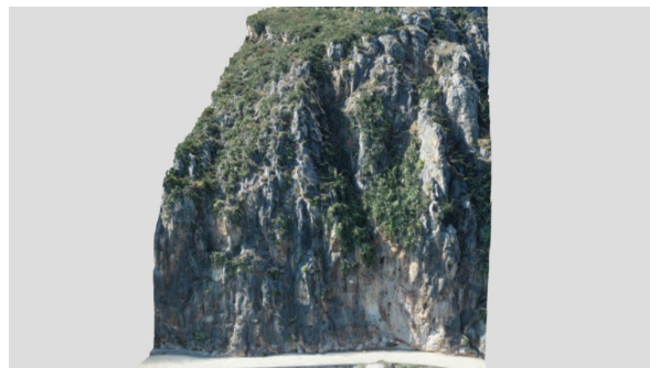
Νότιο πρανές, Τμήμα 3D-4
