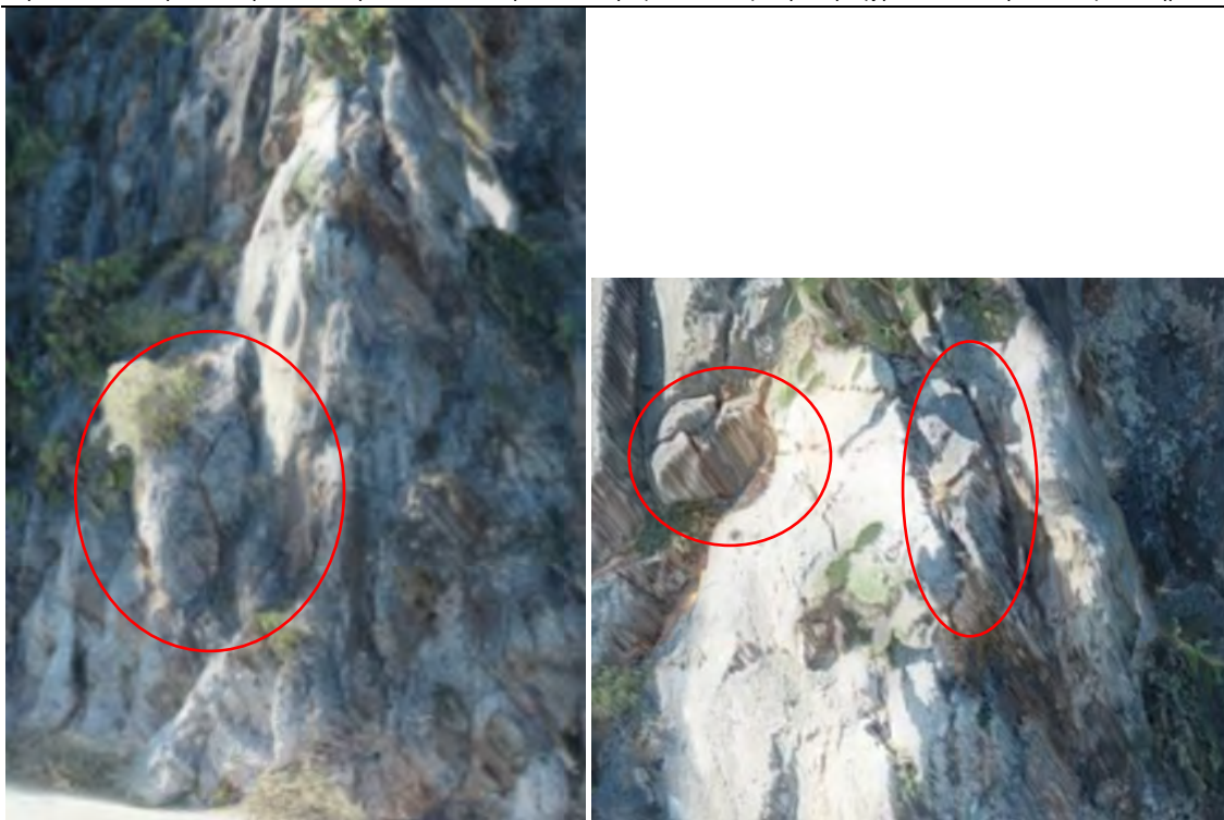
Άποψη του πρανούς N2 όπου σημειώνεται με κόκκινο δυνητικές ολισθήσεις τεμαχών
