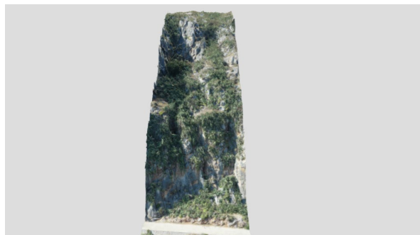
Νότιο πρανές, Τμήμα 3D-5
