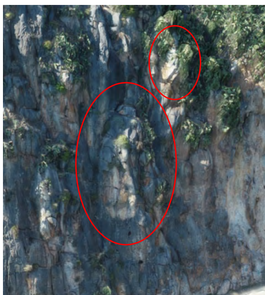
Άποψη του πρανούς N6 όπου σημειώνεται με κόκκινο δυνητικές ολισθήσεις τεμαχών
