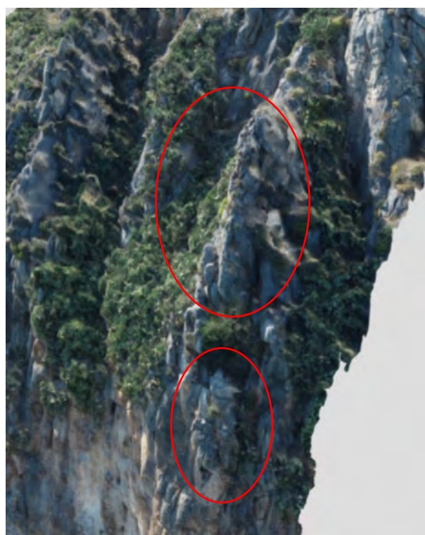
Άποψη του πρανούς N6 όπου σημειώνεται με κόκκινο δυνητικές ολισθήσεις τεμαχών
