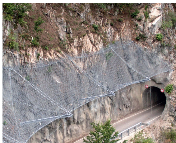
Εικόνα 6.2. Παραδείγματα τοποθέτησης εύκαμπτων σκεπάστρων (Flexible gallery structures)
