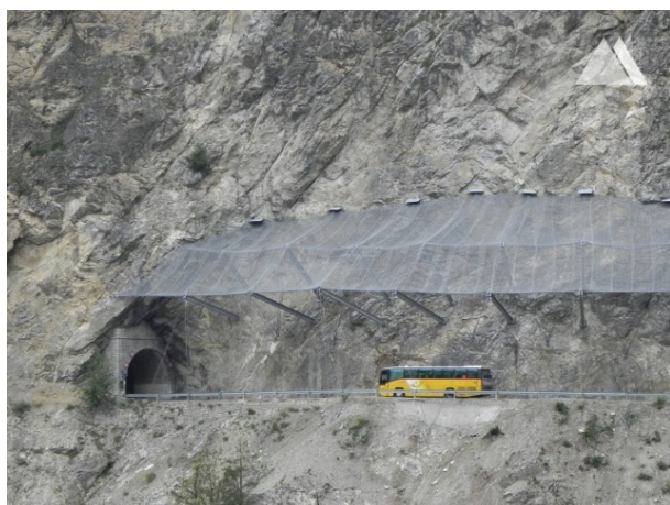
Εικόνα 6.2. Παραδείγματα τοποθέτησης εύκαμπτων σκεπάστρων (Flexible gallery structures)
