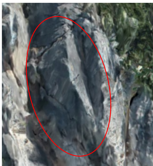
Εικόνα 5.4. Χαρακτηριστική περίπτωση επισφαλούς τεμάχους, στη θέση του τμήματος N0
