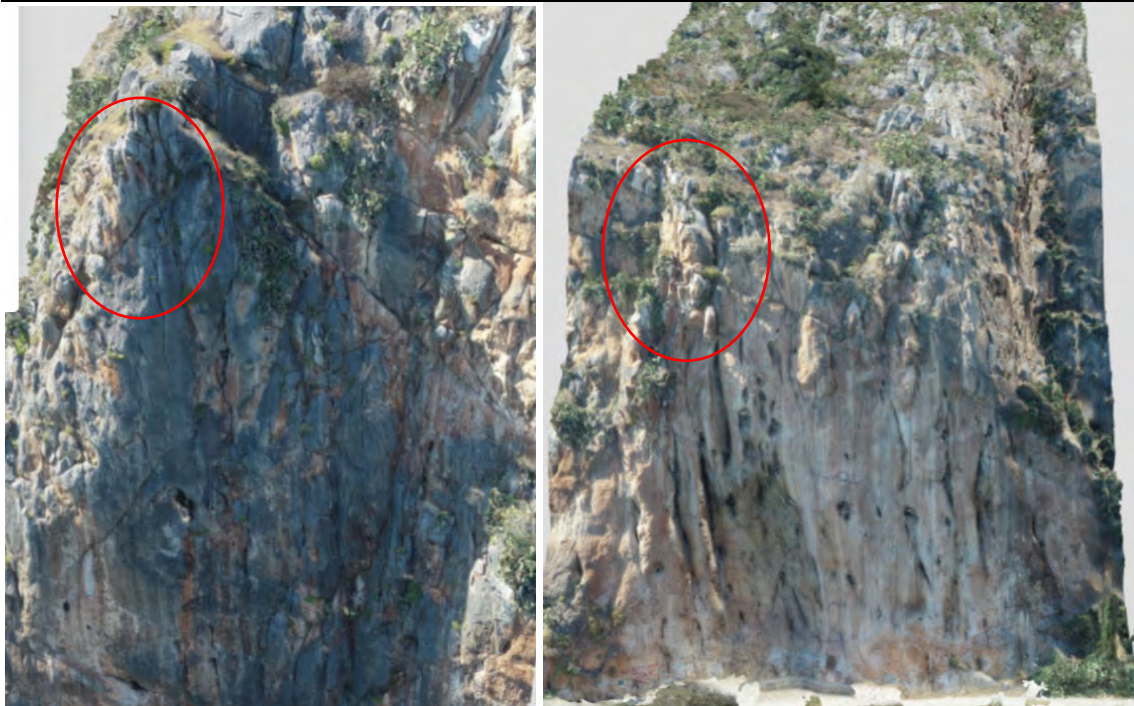
Άποψη του πρανούς N8 όπου σημειώνονται με κόκκινο δυνητικές ολισθήσεις τεμαχών
