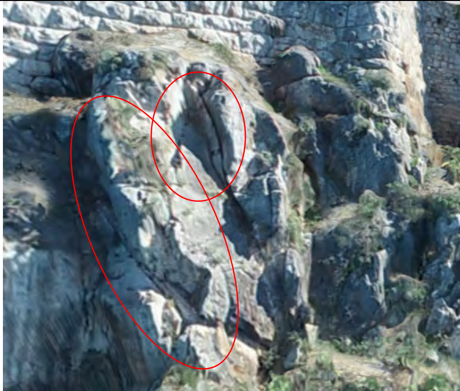
Άποψη του πρανούς B2 όπου σημειώνονται με κόκκινο δυνητικές ολισθήσεις τεμαχών
