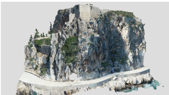
Νότιο πρανές, Τμήμα 3D-1
