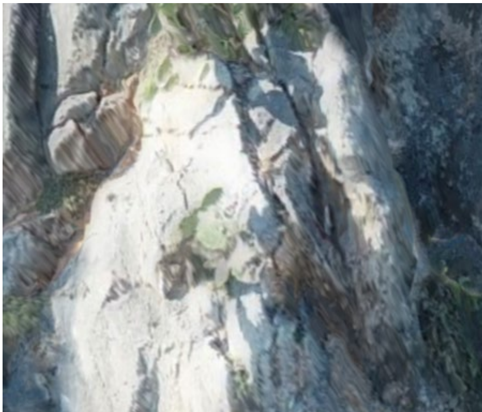
Εικόνα 5.9. Χαρακτηριστική περίπτωση επισφαλούς θέσης σε επίπεδη ολίσθηση, στη θέση τμήματος N2
