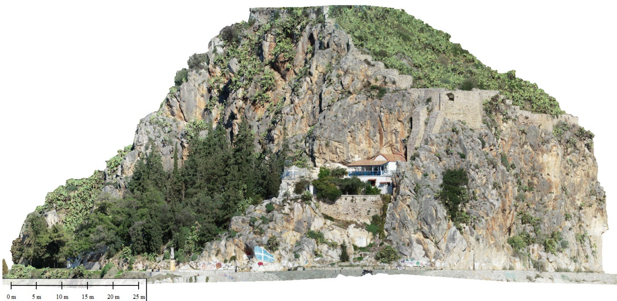
Εικόνα 3.20. Ορθο-φωτο-μωσαϊκό του προφίλ στη θέση Φάρος που προκύπτει από την επεξεργασία των δεδομένων που ελήφθησαν από πτήσεις κάθετα στο πρανές.
