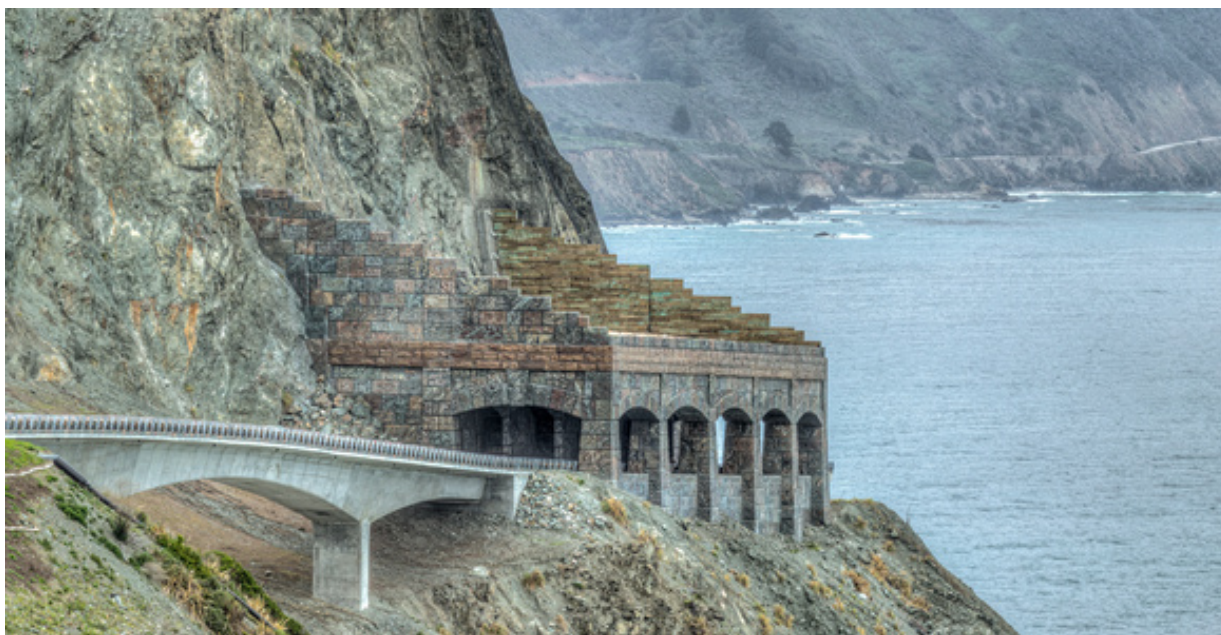
Εικόνα 6.3. Κατασκευή σκέπαστρου από οπλισμένο σκυρόδεμα (rock shed) επενδυμένου με λιθοδομή (Rain Rocks Rock Shed, California)
