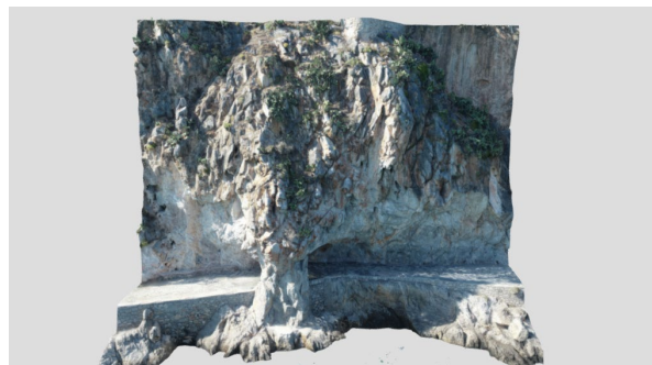
Νότιο πρανές, Τμήμα 3D-2
