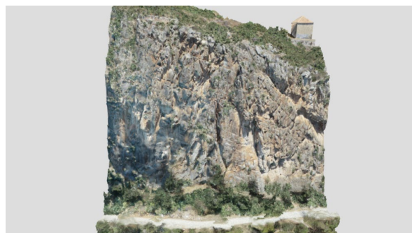
Νότιο πρανές, Τμήμα 3D-8
