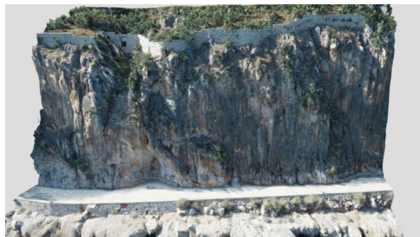
Νότιο πρανές, Τμήμα 3D-3
