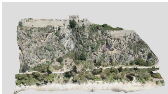
Νότιο πρανές, Τμήμα 3D-9
