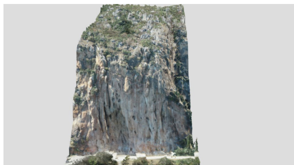
Νότιο πρανές, Τμήμα 3D-7
