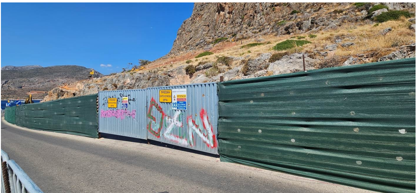
Φωτ. 2 Εργοταξιακή περίφραξη κατά μήκος του δρόμου στην αφετηρία του Σταθμού.
