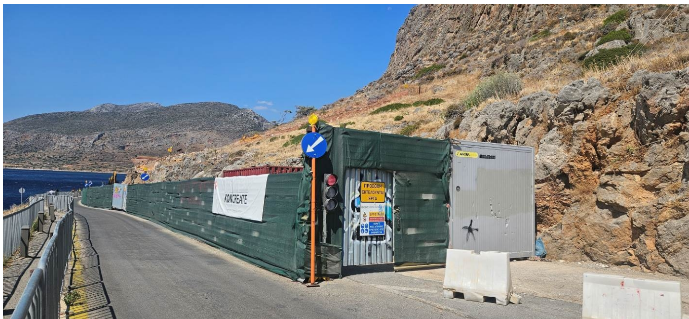
Φωτ. 3 Εργοταξιακή περίφραξη κατά μήκος του δρόμου στην αφετηρία του Σταθμού, όπου φαίνονται και δύο container.
