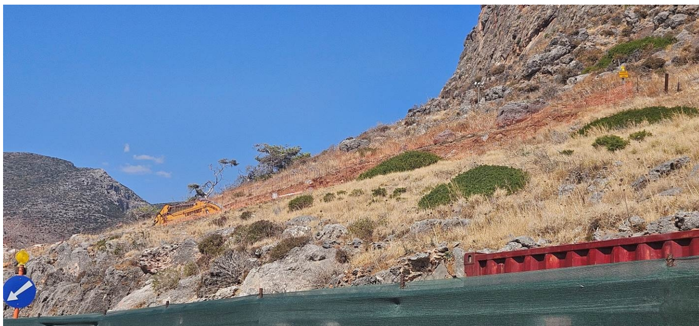
Φωτ. 4 Θέση όπου πρόκειται να κατασκευαστεί ο Σταθμός Αφετηρίας, όπου υπάρχει επίσης εργοταξιακή περίφραξη και ένα μηχανήμα έργου
