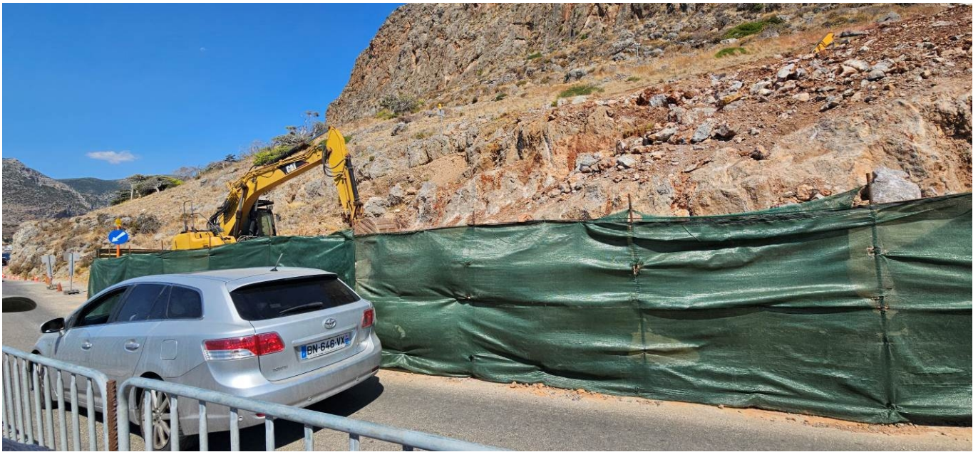
Φωτ. 1 Εργοταξιακή περίφραξη κατά μήκος του δρόμου στην αφετηρία του Σταθμού όπου φαίνεται και το μηχάνημα έργου.
